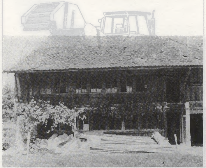
Construite à poteau et coiffée d'une toiture réveillonnée, cette ferme date de 1799.
