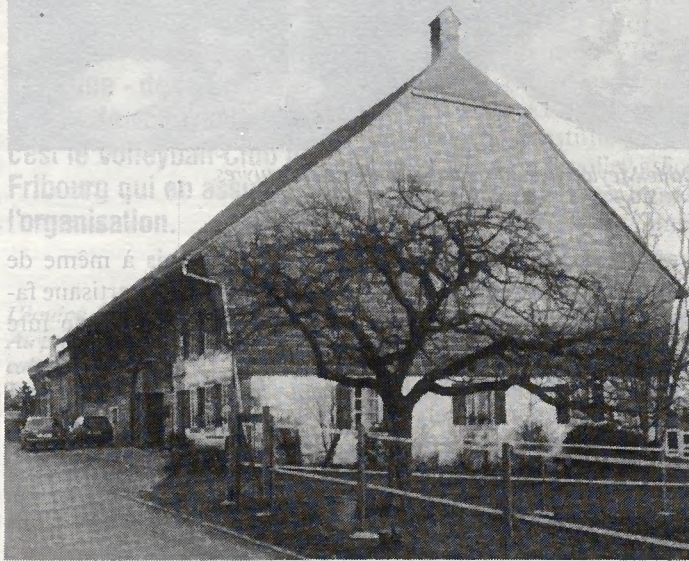
Ferme dotée d'un logis, construite en 1855.
