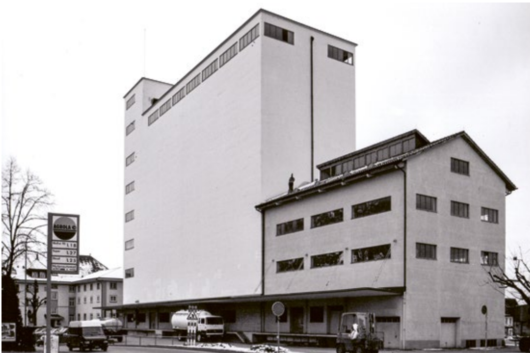
Guin, silo à céréales, ingénieurs Jakob Wyrsch (Zurich, projet), Beda Hefti (Fribourg, travaux), 1939-1940. Silo commandé par l'Administration fédérale des blés pour l'approvisionnement de la population en temps de crise. Autre construction emblématique pour la simplicité et la modernité des formes après le silo à malt de la brasserie Cardinal d'Henri Gicot, 193-1935.
