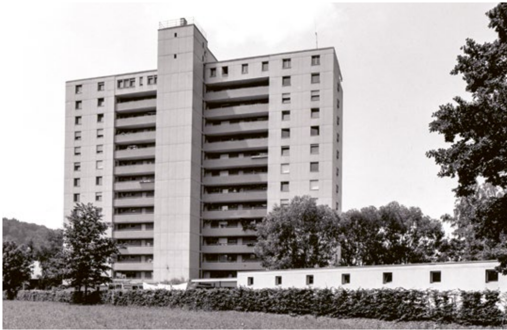
Flamatt, tour d'habitation, architecte Hans-Rudolf Spycher, 1960-1961. Tour d'habitation moderne de 14 étages à coursives, sur le modèle du quartier résidentiel Tscharnergut à Berne-Bümpliz (1958-1966). Les parapets et les escaliers ont sous doute été préfabriqués par Element AG à Tavel.
