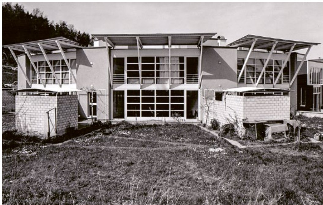
Schmitten, maisons mitoyennes Tridem, architectes Thomas Urfer et Jean-Marc Ruffieux, 1984-1987. Maisons bleues avec façade ouverte sur le paysage et larges avant-toits. Plans ouverts sur deux étages, escaliers et sanitaires concentrés dans l'axe.
