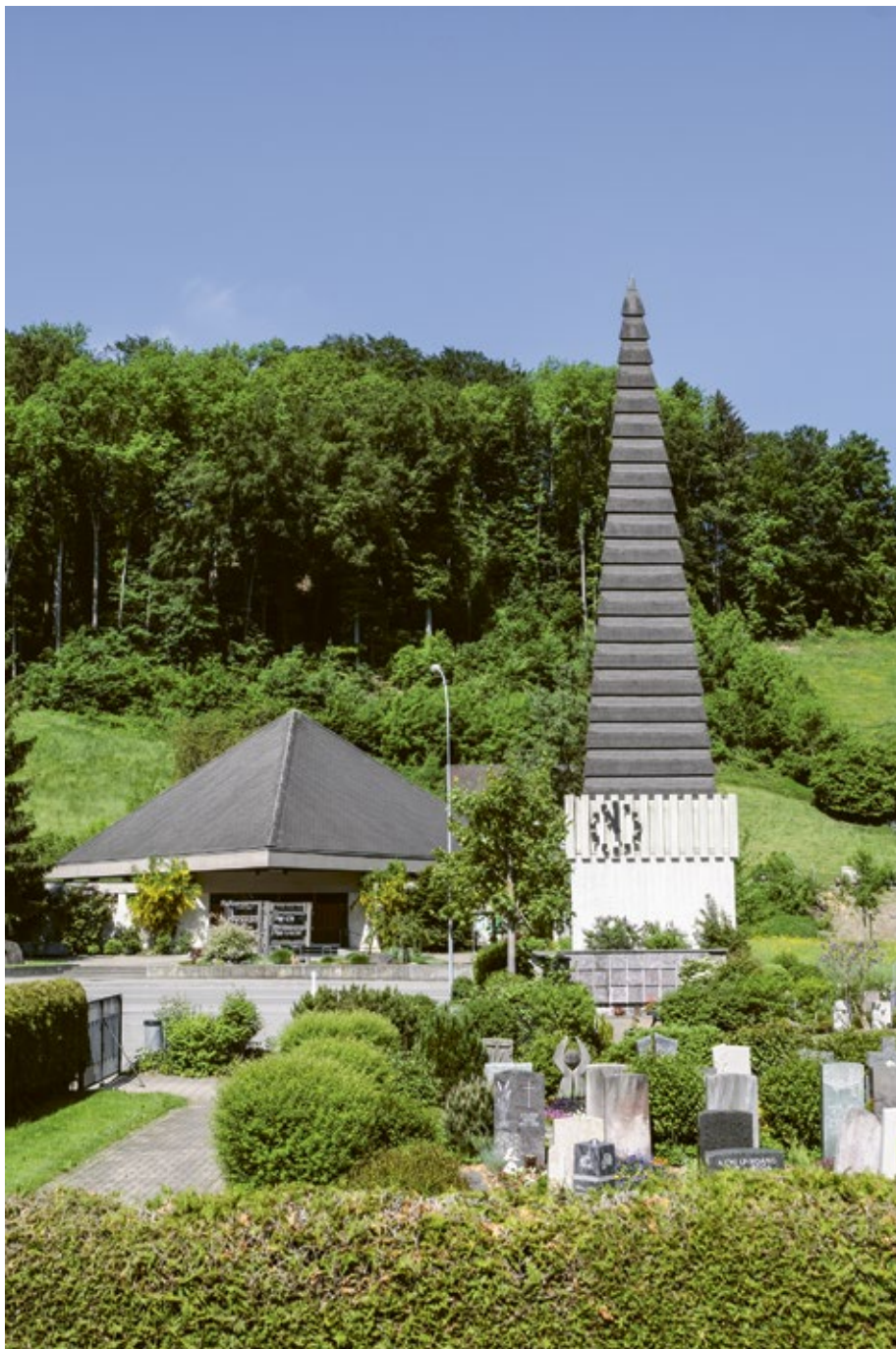
Flamatt, église réformée, architectes Fred Knapp et Jürg Stämpfli, 1963-1965. Projet sur la base d'un triangle équilatéral pour le plan et de triangles à angles aigus pour l'élévation, tour en forme de pyramide pointue à trois faces. Aménagement intérieur selon la nouvelle liturgie, avec les bancs des fidèles placés des trois côtés autour de l'autel.
