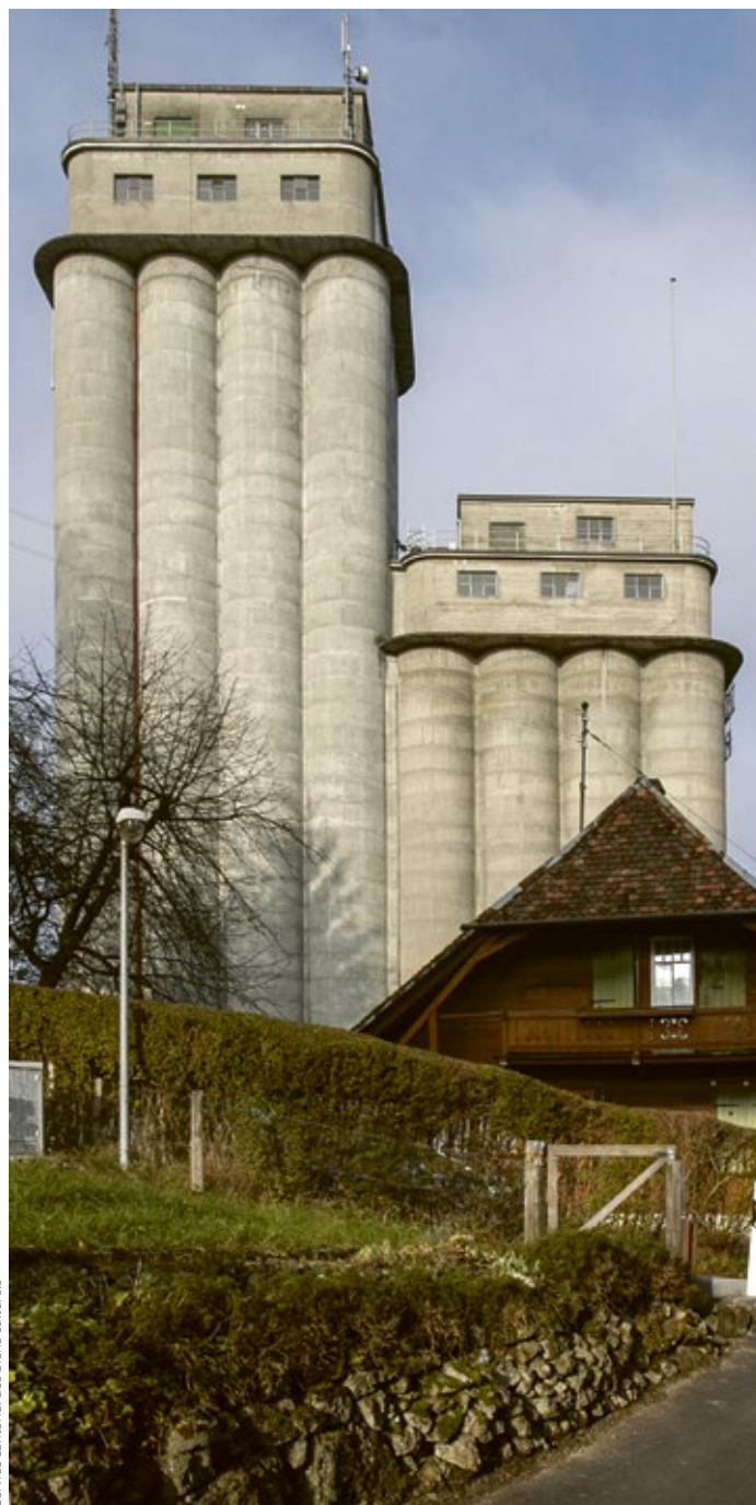
Flamatt, Futtermittelsilos Minoteries de Flamatt SA, ingénieurs Maurice Hartenbach et Ernst Wenger (Berne), 1947 et 1958. Constructions en béton apparent à 12 cylindres, de 30 m et 50 m de haut.
