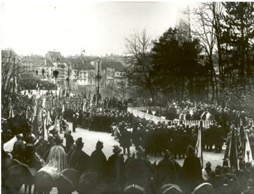
Inauguration du nouveau Pont de Zähringen, remplaçant le Grand Pont suspendu, en 1924, au temps où les Conseillers d'Etat (ici Victor Buchs) tiennent leurs discours encore intégralement en français.
