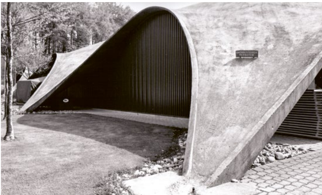
Guin, halle de tennis, ingénieur Heinz Isler (Burgdorf), 1977-1978. Construction sans supports, à parois fines, avec répartition naturelle (et non géométrique) des forces, système breveté par Heinz Isler, ingénieur à la carrure internationale.
