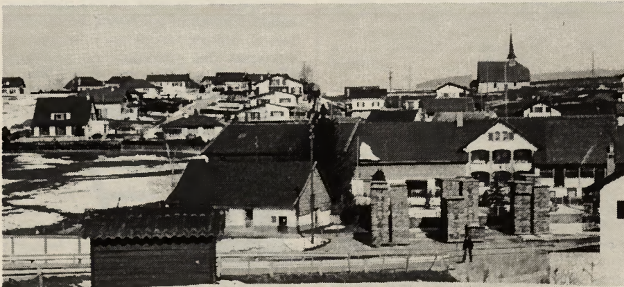
Depuis quelques années, Vaulruz connaît un réjouissant développement de caractère résidentiel. Pour preuve le quartier de la chapelle, comme on l'appelle communément dans ce village. Au premier plan, la scierie Jo Bertherin.
