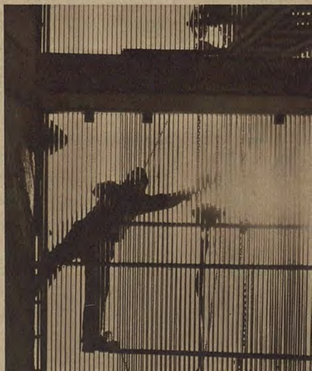
Greizersee. Am 7. Mai 1948 wurde das Gitter der Wasserfassung für die Druckleitung geschlossen.
