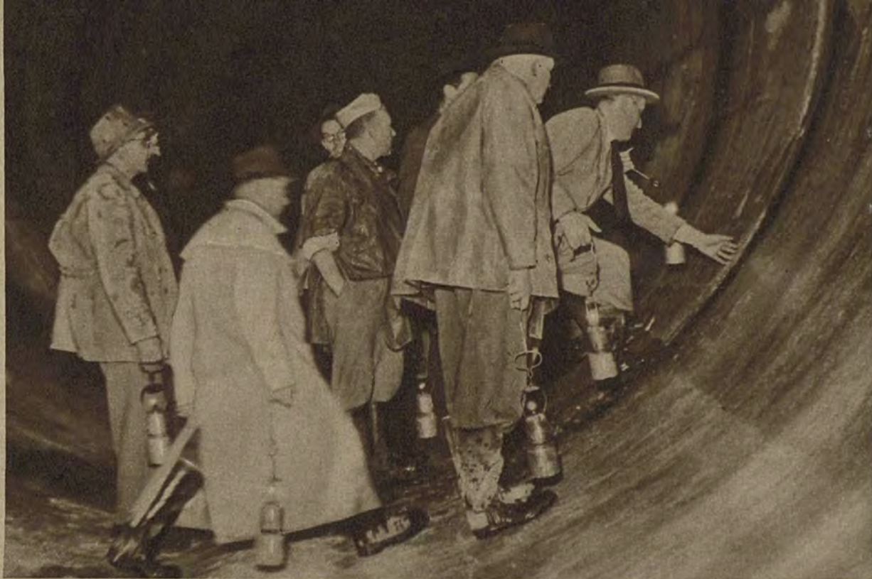
Greizersee. Mit prüfenden Blicken wird der Druckstollen abgesehen. Dieser ansehnliche unterirdische Kanal hat einen Durchmesser von 5 Meter.
