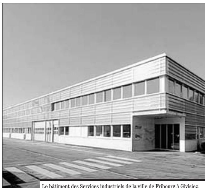
Le bâtiment des Services industriels de la ville de Fribourg à Givisiez.
