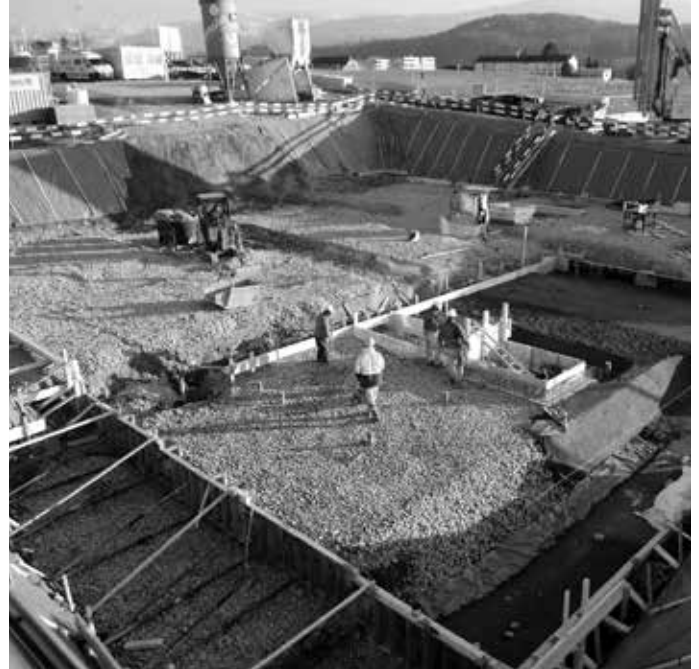
Chantier de l'école de Grand-Pré
