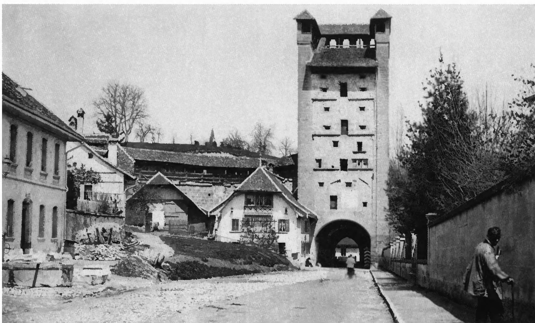
Porte de Morat, avant l'élargissement de la rue.
