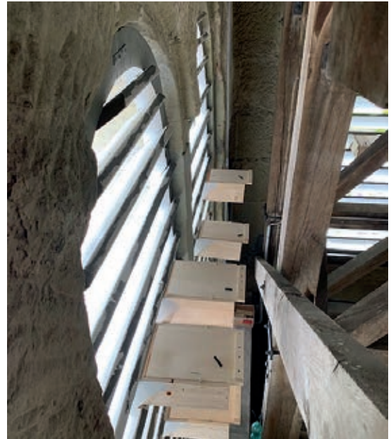
Brutkästen für Mauersegler am Kirchturm.
