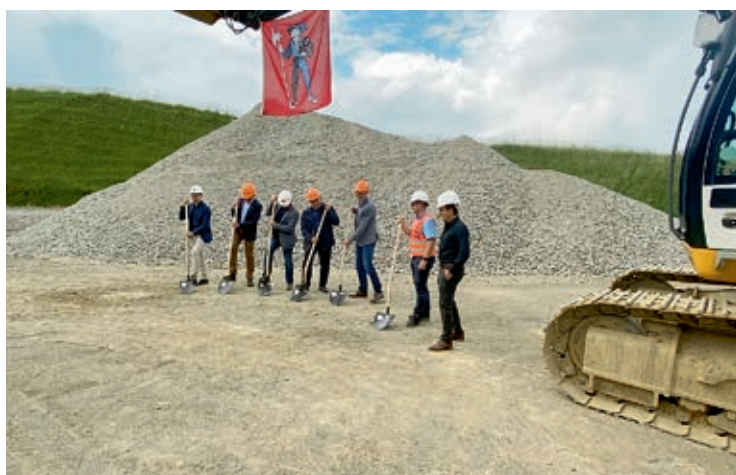
Spatenstich für das neue Mehrzweckgebäude Tafers.
