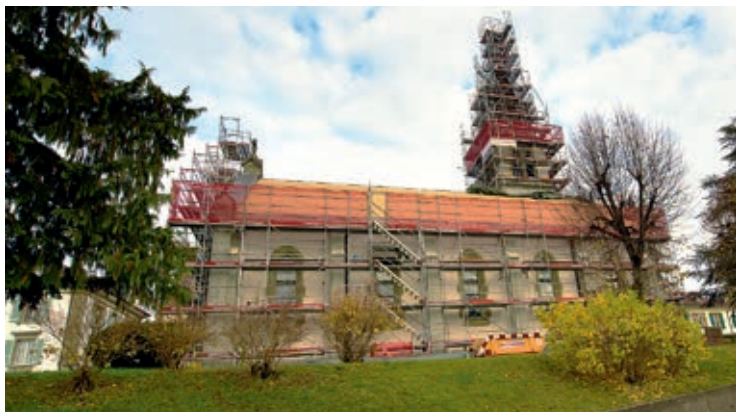
Dach und Fassade der Pfarrkirche St. Mauritius bei der Renovation.
