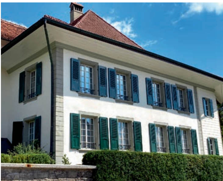
Die sanierte Südfassade des Pfarrhauses.
