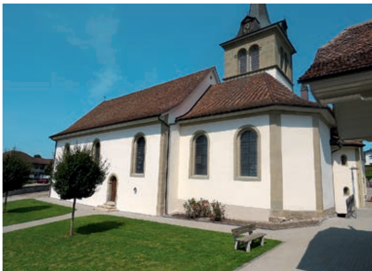
Südseite der Kirche St. German nach der Renovation.
