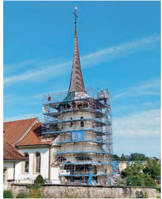
Kirchturmsanierung Tafers im Sommer 2021.
