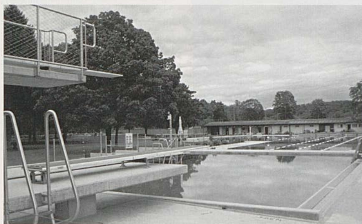
Die Regio Badi in Laupen wurde erneuert und ausgebaut.
