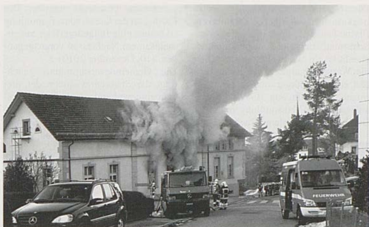
Ein Brand richtete im Pfarreizentrum grossen Schaden an.
