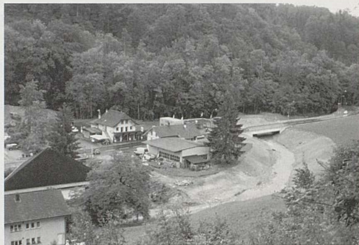
Die Taverna fliesst in Flamatt in einem neuen Bett.
