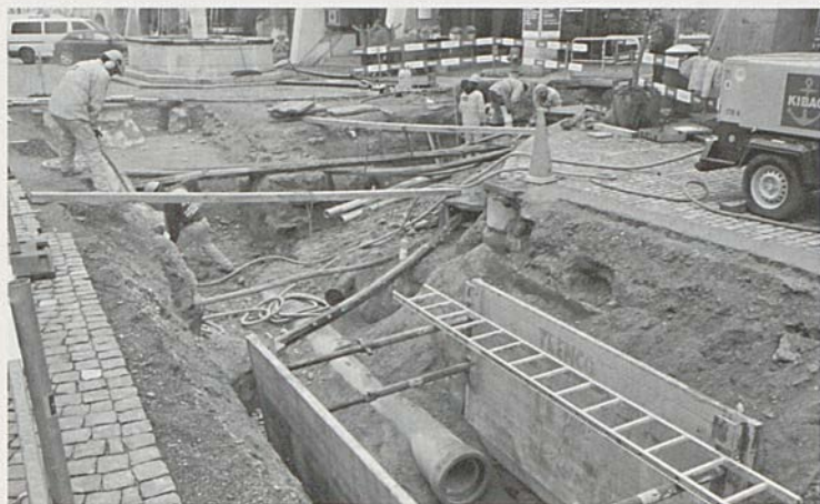
Sanierungsarbeiten in der Hauptgasse Murten. Bild zvg
