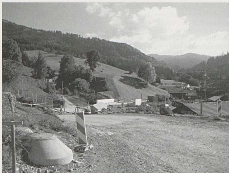
Die Strasse vom Dorf nach Sageboden wird saniert.
