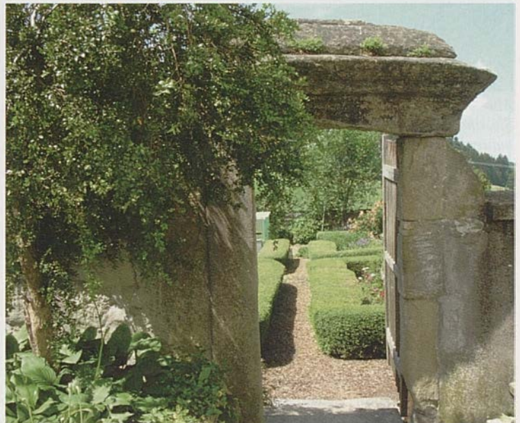
Abb. 6: Die zwei Eingangstüren – hier die Türe im Süd-Osten – in der Gartenmauer weisen einen profilierten Türsturz aus Sandstein auf. Es dürfte sich dabei um den ursprünglichen Zustand handeln.
