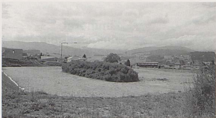
Erdverschiebungen für den zweiten Fussballplatz.
