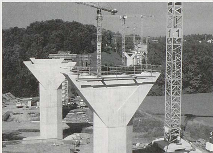
Die Poya-Brücke wächst.
