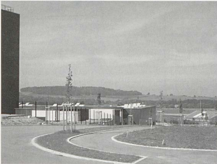
Die Fein- und Groberschliessung der Arbeitszone Birch ist abgeschlossen.
