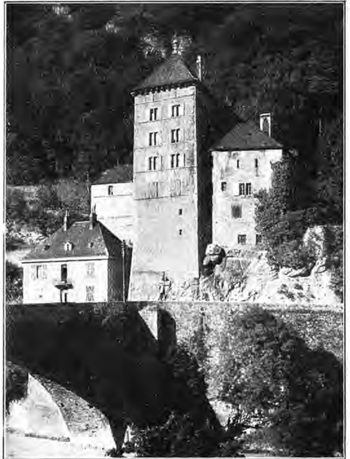
Schloß und Rhonebrücke im Engpaß von St. Maurice, die jahrhundertelange Sperre zur „Pforte des Wallis“.
