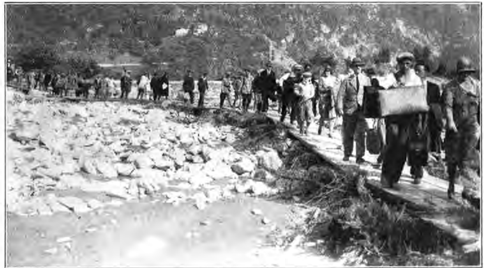
Neue Verheerungen des Barth/Leimbaches im Unterwallis haben bei St. Maurice Eisenbahn und Straße verschüttet und unterbrochen. Der Verkehr mußte über Notstege aufrecht erhalten werden.
