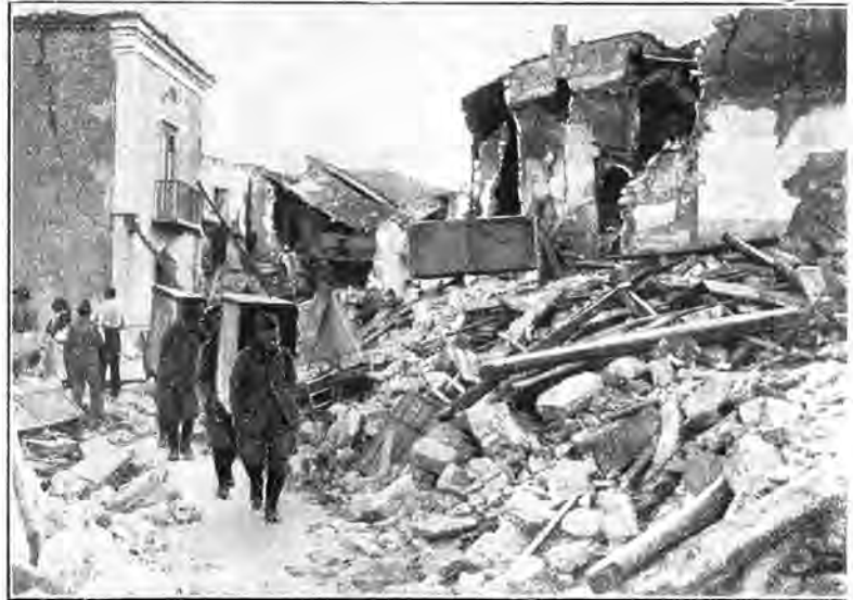
Militär bei Aufräumarbeiten im völlig verwüsteten Villanova.
