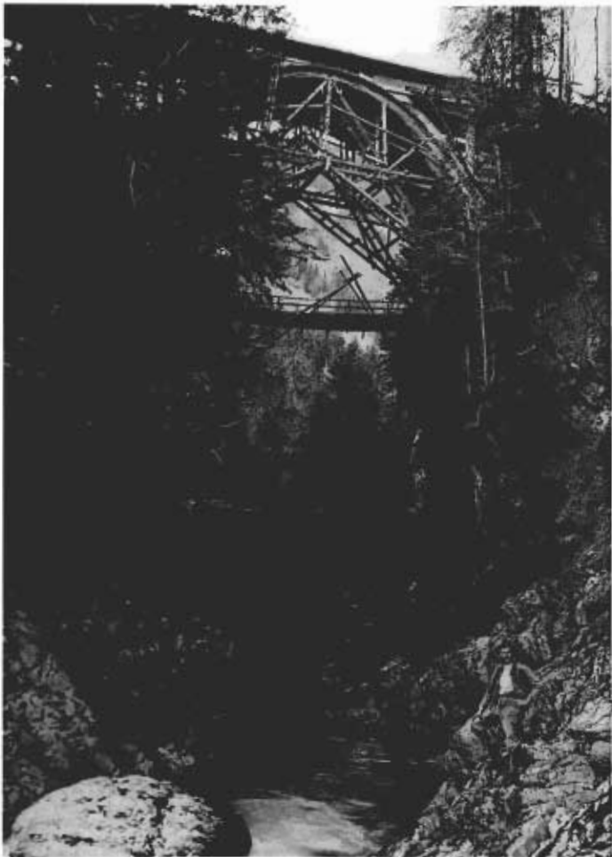
Le pont de la Gîte-des Planches lors de son achèvement en 1898 (longueur 51 m, hauteur 36 m).
