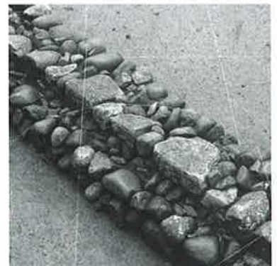
Abb. 18 Detail zweier sich überlagernder Mauern
