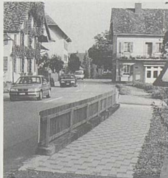
Zwischen Schulhaus und Friedhof wurde ein Gehweg realisiert.
