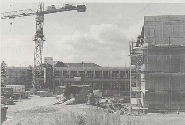
Der Bau des neuen Orientierungsschulhauses schreitet planmässig voran (Foto vom Stand anfangs September).
