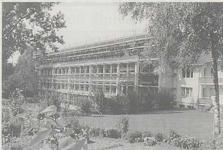
Das Schulhaus wird gegenwärtig für über 2 Millionen Franken um- und ausgebaut.
