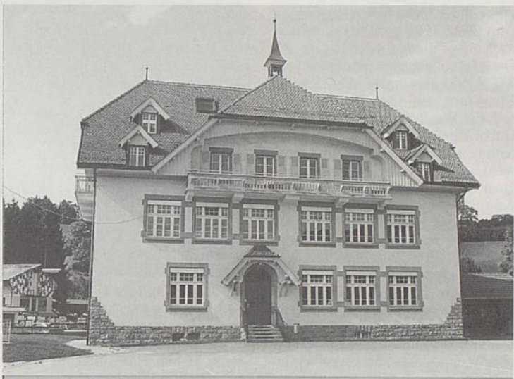
Nach dem Auszug der Gemeindeverwaltung Oberschrot nach Niederried steht das Oberschrot-Schulhaus nun als Ganzes der Schule zur Verfügung.
