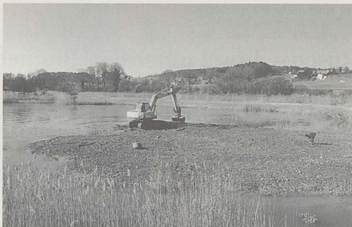
Baggereinsatz als Ersatz für die verschwundene Flussdynamik (Foto: Jacques Studer)
