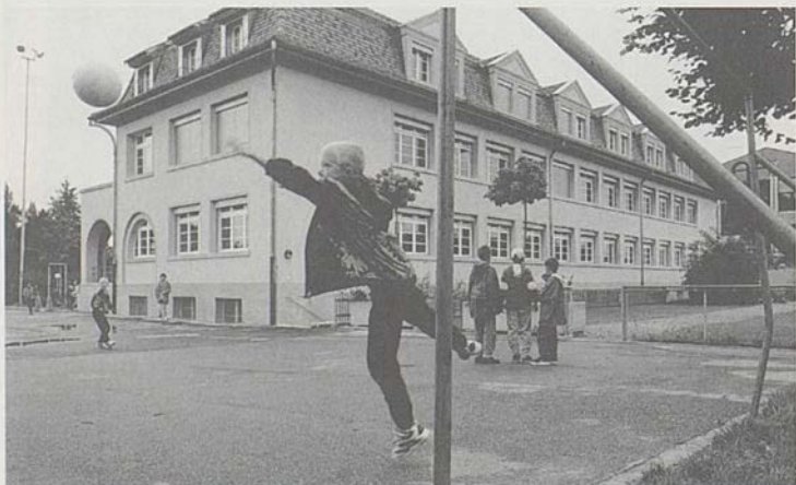
Das Schulhaus wurde im Sommer 1997 einer Totalrenovation unterzogen. (Foto Aldo Ellena, Plaffeien)
