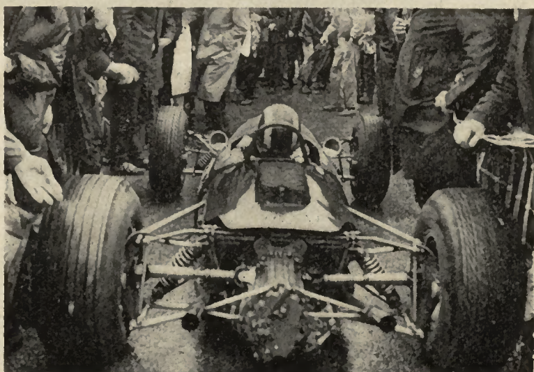
La boîte de vitesses et les gros axes de roues sont prêts à transmettre sur la route toute la puissance du moteur.
