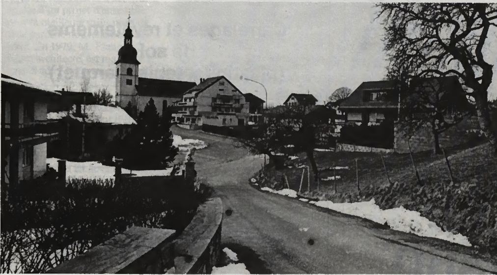
Une vue de Remaufens et de son clocher reconnaissable entre tous en Veveysse.
