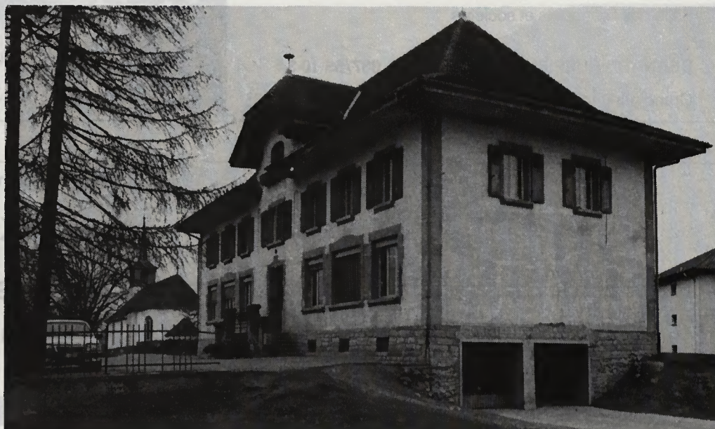
Le bâtiment scolaire qui abrite également l'administration communale.
