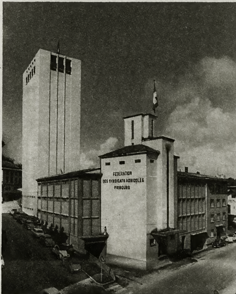
Vue générale des constructions de la Fédération des syndicats agricoles et, à l'arrière-plan, les nouveaux silos d'une contenance de 2300 tonnes.
