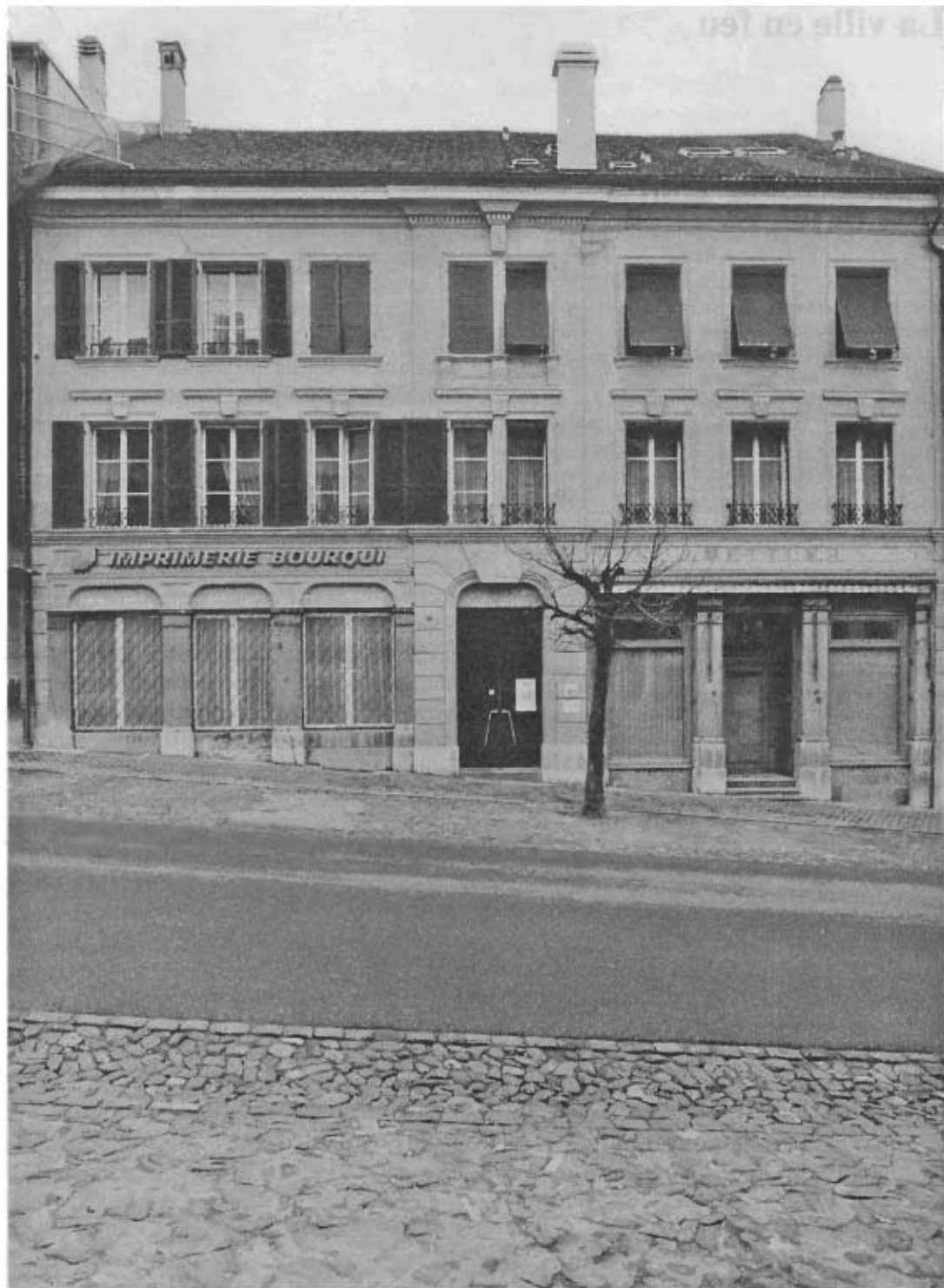
Rue de l'Eglise 73 - Ce grand bâtiment construit sur les plans de l'architecte Joseph-Emmanuel HOCHSTÄTTLER a remplacé deux maisons détruites en 1863.
