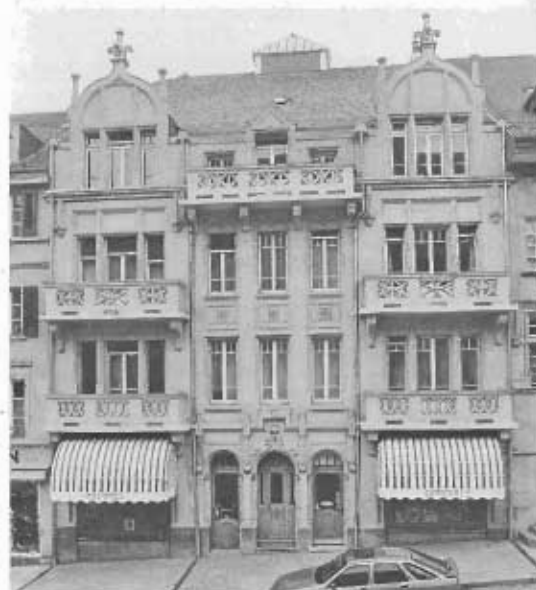
NÉO-GOTHIQUE - Grand-Rue 18, ce bâtiment construit en 1905 est l'un des réussites incontestables de l'architecte fribourgeois LÉON HERTLING
