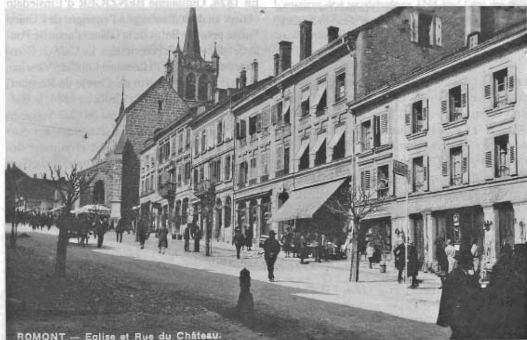
A la rue de l'Eglise, l'ensemble conçu par l'architecte Josef-Emmanuel HOCHSTÄTTLER de Fribourg, ancien intendant des bâtiments de l'Etat, 1863 (d'après une carte postale du début du siècle)
