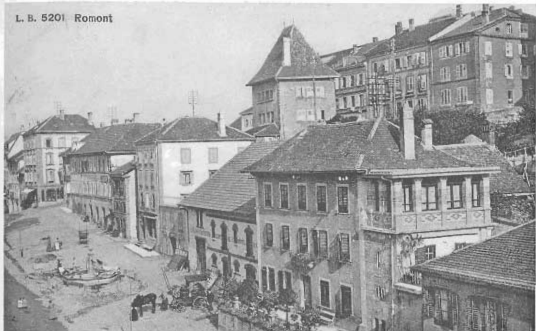
La Grand-Rue, vers 1910, avec l'une des dernières écuries d'hôtel. La tour dite des Béguines ou du grainetier passe pour être l'un des éléments de la première enceinte de la cité. Déjà signalée comme telle en 1550, elle servit de grenier d'épargne jusqu'au milieu du XIX e siècle. On y aménage ensuite une laiterie, un atelier d'horlogerie en 1854, des salles de classe puis une cuisine militaire
