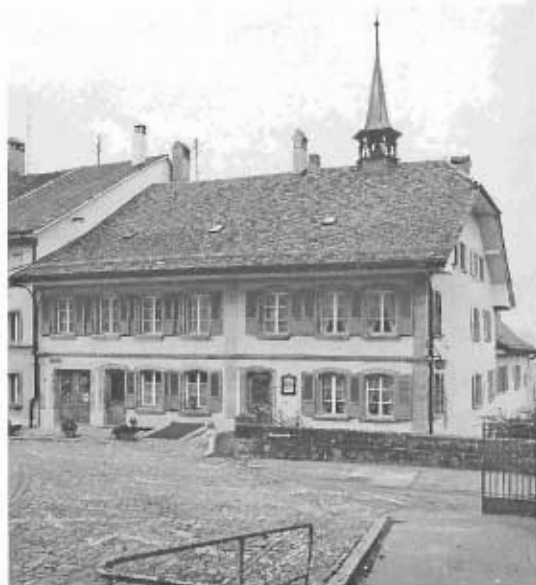
BAROQUE - Rue des Moines 68-70, cure protestante, ancienne maison de REYNOLD, reconstruite dans le dernier quart du XVIII e siècle, avec maintien de nombreux éléments gothique tardif
