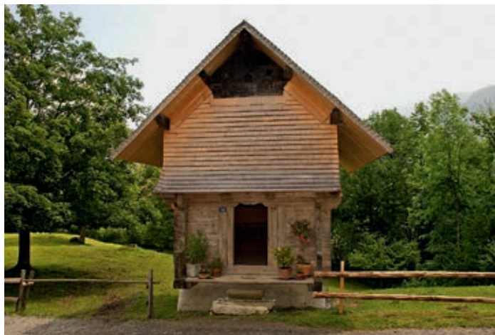
7) Der versetzte und im Freilichtmuseum Ballenberg im Jahr 2003 wiederaufgebaute Pfarrspeicher von Heitenried. Die zwei Bauphasen von 1652 (Erdgeschoss) und 1761 (Obergeschoss) sind gut ablesbar.
