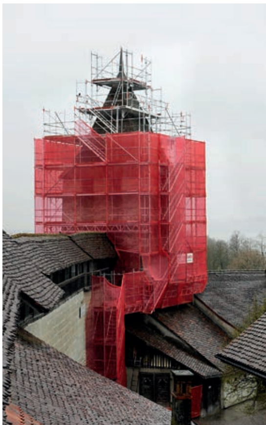
Die Gemeinde Murten hat 2013 den Hexenturm saniert. Bild Archiv Lib./Corinne Aeberhard
