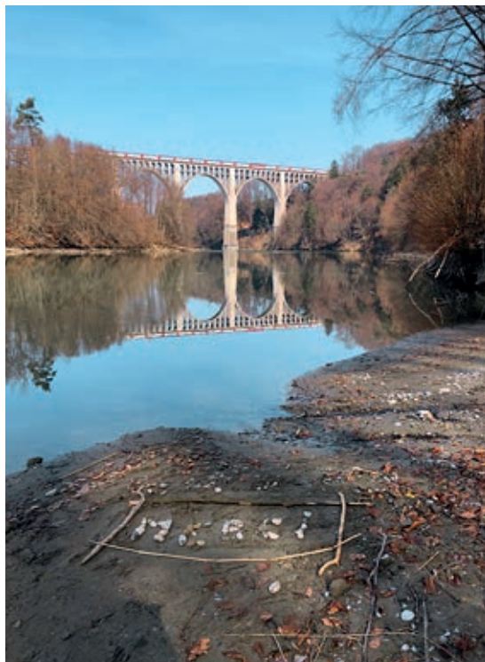
Die Grandfeybrücke heute, der Angelpunkt der Bahnen im Kanton Freiburg. Bild André Schneuwly
