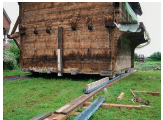
3) Verschiebung des Speichers Brunner in Lustorf im Jahre 2006. Der Traktor zieht den Speicher auf improvisierten Schienen über sechzig Meter an den neuen Standort. Bild Jean-Pierre Anderegg
