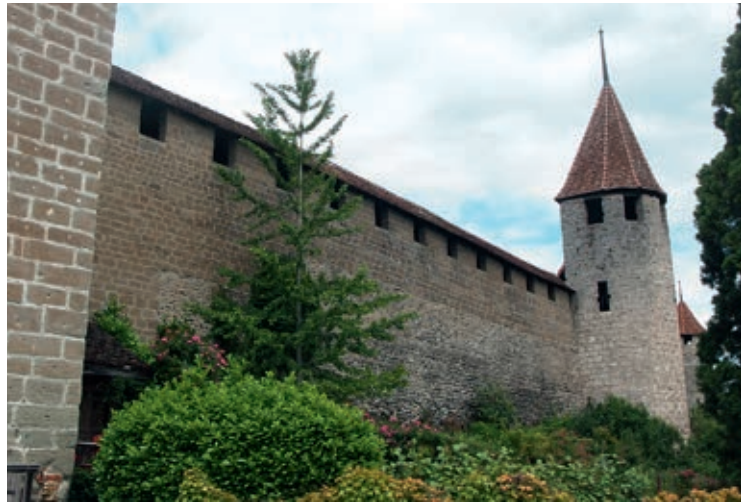
Blick auf den Stadtgraben-Garten und den Mauerabschnitt zwischen Törlplatz und Tournaletta. In diesem Mauersektor sind die verschiedenen Bauphasen besonders deutlich erkennbar. Die Ringmauer weist hier ihre maximale Höhe von fast sechzehn Metern auf. Bild Yvonne Jungo
