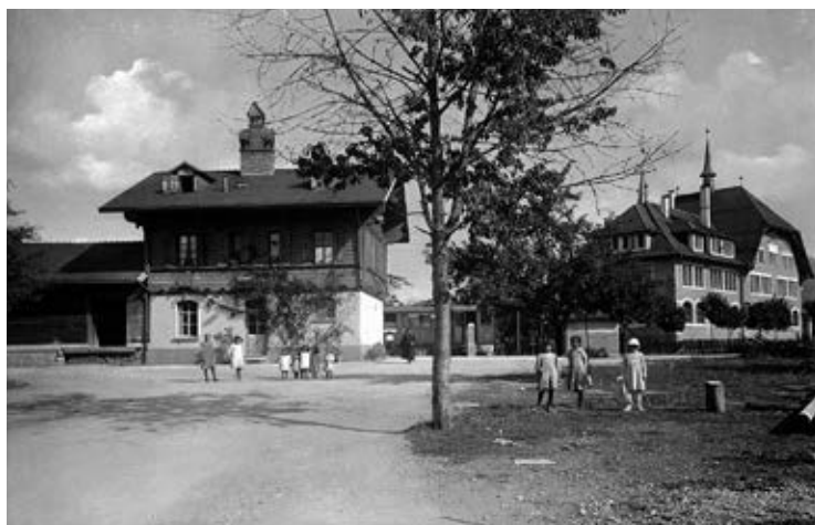
Bahnhof und Schulhaus Broc um 1919. Bild Charles Morel/Musée gruérien Bulle
