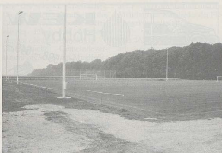
Der Sportplatz Erli erhielt eine Flutlichtanlage.
