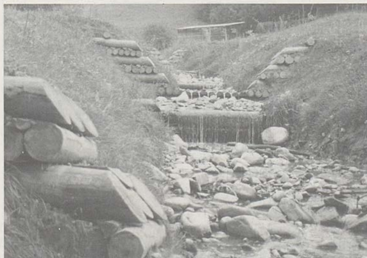
Das Brandbächlein wurde naturnah verbaut.
