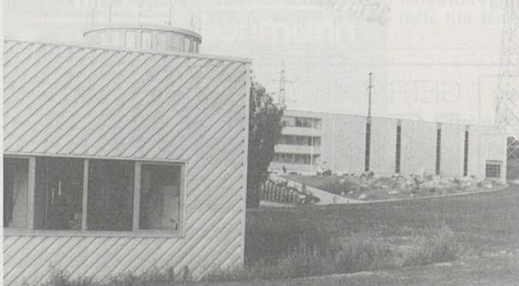
Mit der Realisierung neuer Gewerbezonon – im Bild die Gewerbezone Brügelfeld – wird die nördliche Dorfansicht stark verändert.
