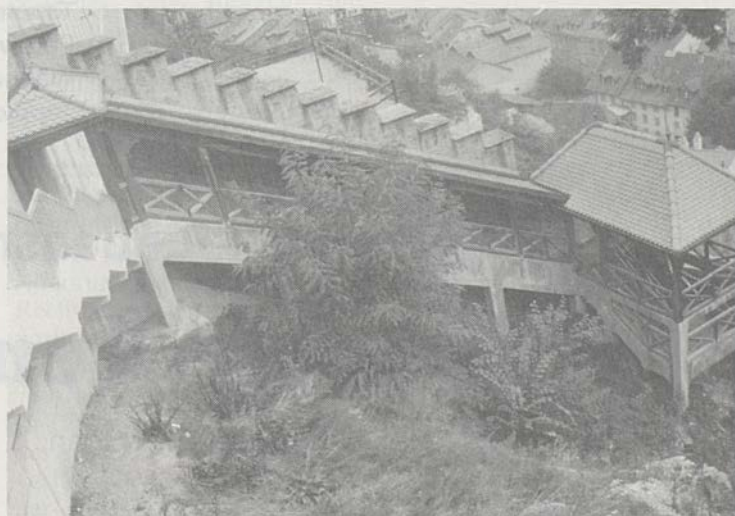
Die Funiculaire-Treppe wurde für 1,4 Millionen Franken wieder instandgestellt.
