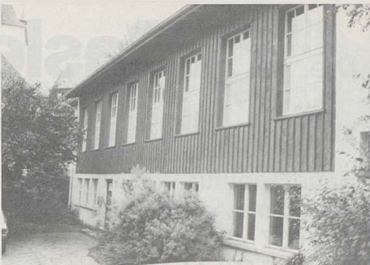
Das Kirchgemeindehaus aus dem Jahre 1957 harret einer Gesamtrenovation.
