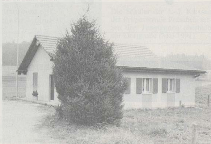
Die renovierte 300 m-Schiessanlage wurde im Okt. 90 eingeweiht.
