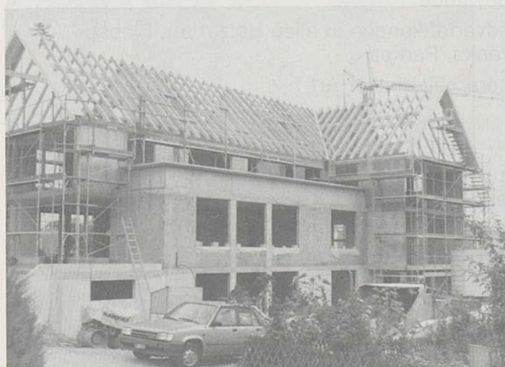
Das Dorfzentrum erhält mit der Überbauung Wirtschaftsmatte ein neues Gesicht.
