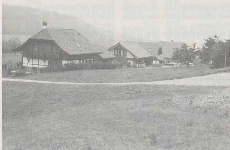
In der Bauzone Rebli soll eine Zivilschutzanlage gebaut werden.
