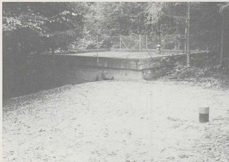
Das Reservoir Arnen wurde saniert.
