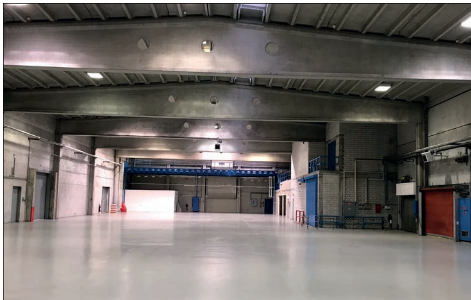
BCU-ROM : halle avant le chantier
