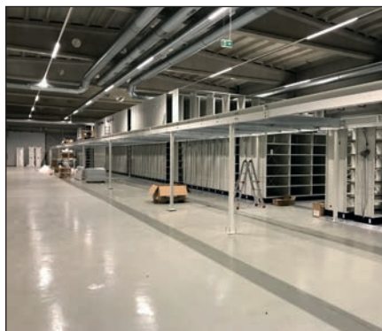
BCU-ROM chantier : montage des étagères mobiles
