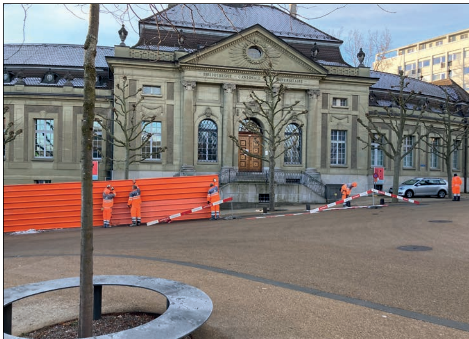
L'entrée principale actuelle avec le montage de la palissade de chantier
