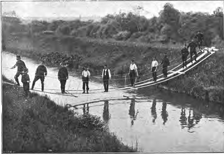
Soldaten erproben ihr soeben erstelltes Drahtbrücklein.
