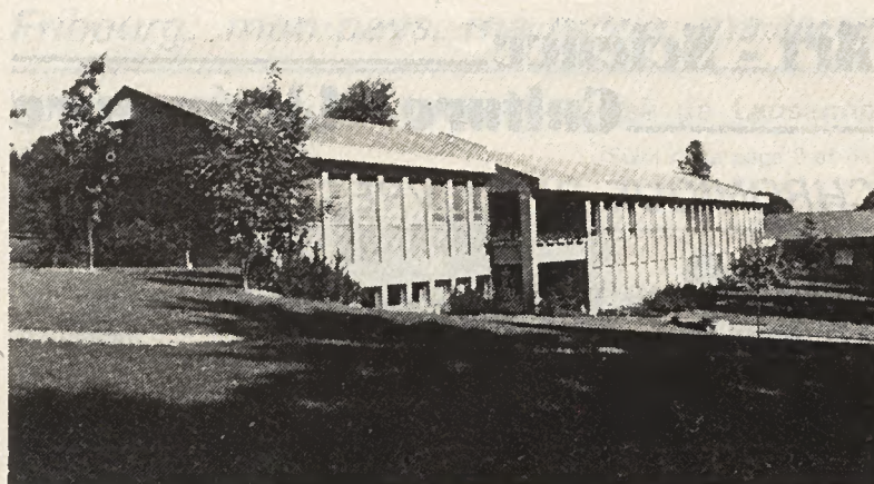
Façade sud-ouest de l'Institut de recherches de l'EFGS
