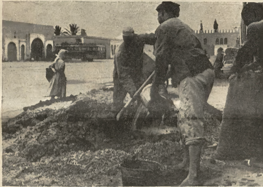
La préparation de ce béton, plus exactement du pisé, mélange de terre rouge, d'eau et de paille coupée en bouts de 5 à 6 cm. Cette mixture servira à construire les habitations des indigènes vivant dans les régions prédésertiques du sud.
