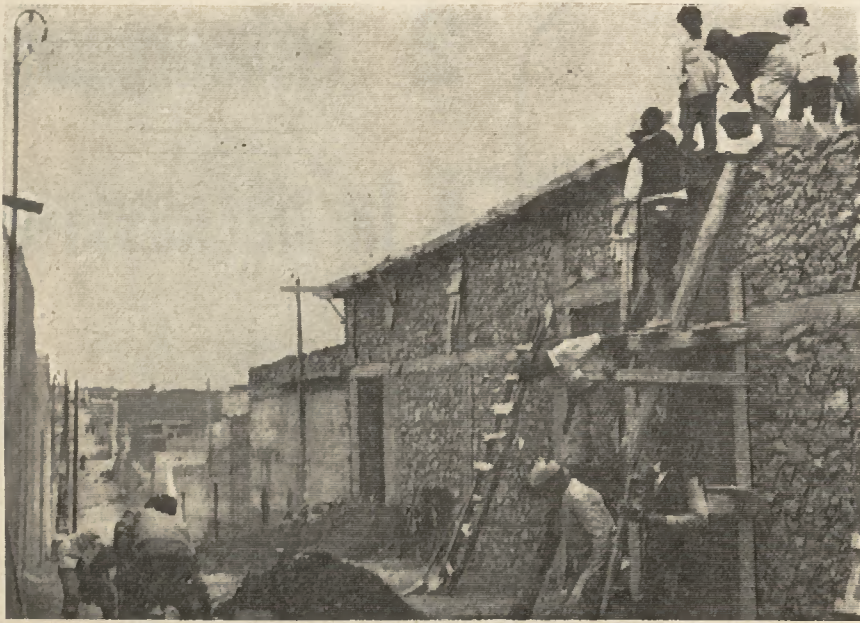
Hé oui ! c'est ainsi que l'on travaille dans le sud à la construction d'une maison. Les maçons font la chaîne et ainsi le « béton » parviendra sur le chantier.
