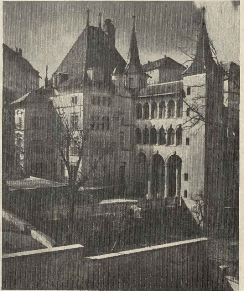
L'Hôtel Ratzé, qui abrite le Musée d'art et d'histoire de Fribourg, fut construit en 1581 par l'architecte français Jean Fumal, pour le compte de Jean Ratzé, commandant de la garde suisse de Lyon. Cet édifice s'inspire de l'architecture lyonnaise de la Renaissance.
