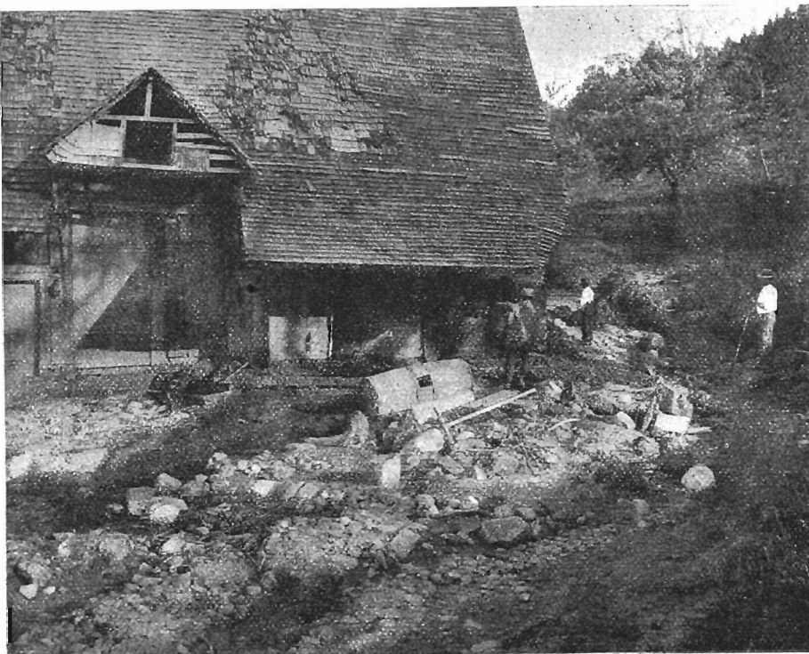
Die Verwüstung beim Hause des Florian Ackermann im Seeliggraben.
