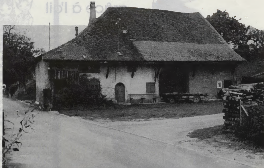
Cette ferme de Châtillon est à sauver des démolisseurs.
