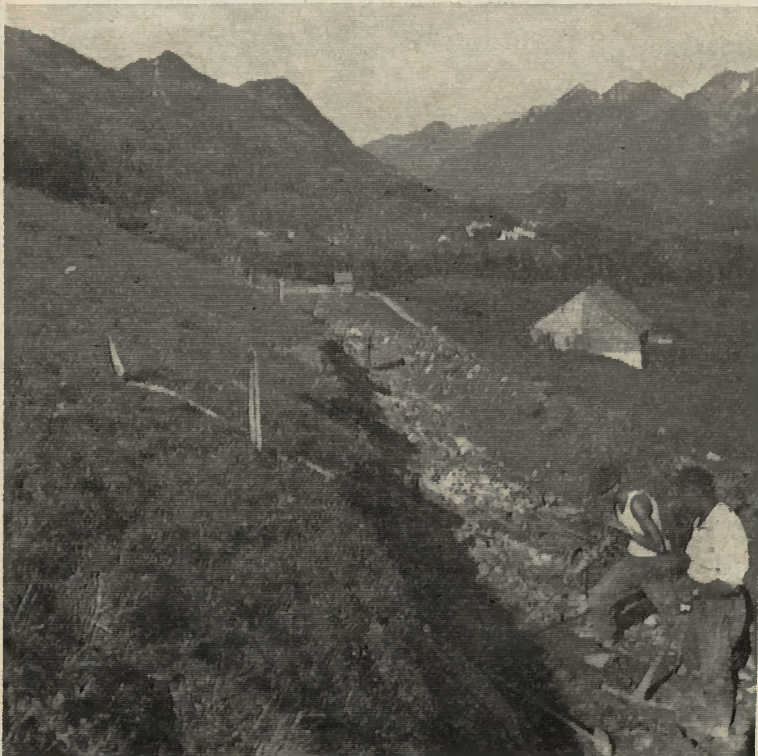
Les travaux de percement près de la Cuvine.
