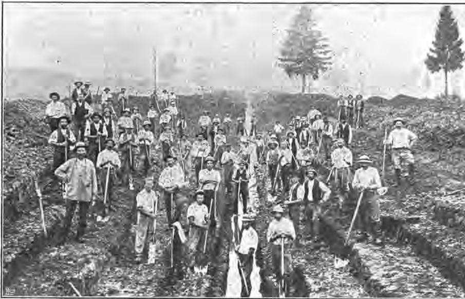
Der Kanalbau in der Langenbühl.
