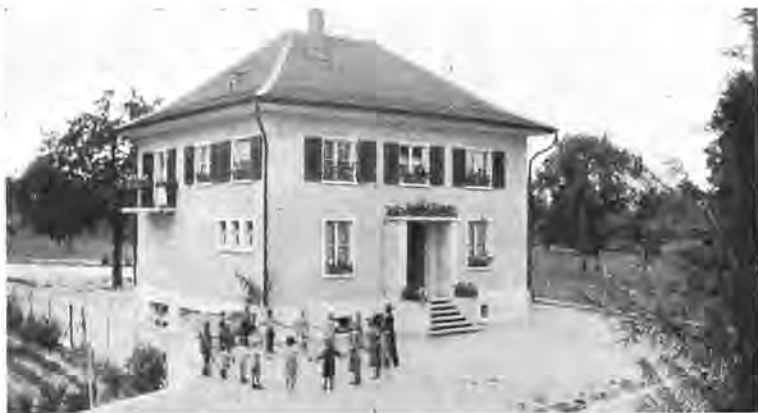
Schulhaus Gutschelmuth. An Stelle des abgebrannten Schulhauses steht nun ein neues. Der Schulsaal bietet 54 Kindern Platz. Unter dem Erdgeschoß befindet sich der lichtvolle Arbeitsaal der Mädchen. Die Lehrerwohnung zählt 5 freundliche Zimmer. Das überaus schmucke Schulhaus gereicht unserm Dörflein zur Zier und dem Erbauer, Herrn Arch. Diener aus Dübdingen, zur Ehr.
