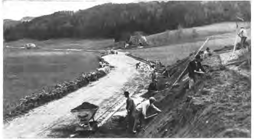
Ausbesserung der Straße in der Langebige. Langebige heißt das Tal zwischen Safers und St. Antoni. Durch das Tal führt die Kantonsstraße, die dem heutigen modernen Verkehr mit seinen schnellen Vehikeln mannigfache Gefahren brachte. Um vielen Arbeitswilligen willkommene Arbeitsgelegenheit zu verschaffen, ist die Straße auf der ganzen Strecke erweitert worden. Manche Krümmungen wurden gänzlich ausgeglichen, andere erheblich gemildert. Wenn man überall „was krumm ist gerade machen wollte“, würden unsere Arbeitslosen noch reichliche Arbeitsgelegenheit finden. Photo: Mithäuser
