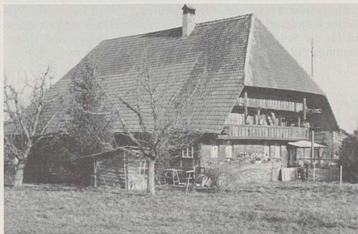
Das schützenswerte Bauernhaus wird renoviert und durch einen zusätzlichen Wohnteil erweitert.
