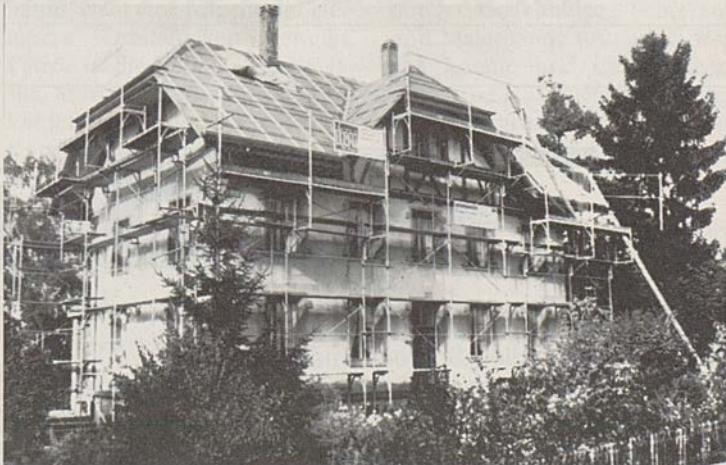
Die Renovation des Pfarrhauses in St. Antoni ist voll im Gang
