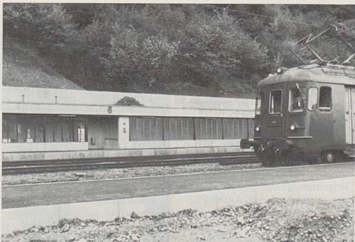
Der Bahnhof Flamatt erfährt seit einiger Zeit bedeutende Umbauten
