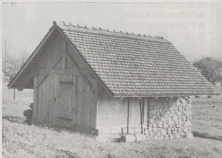
Das gemeindeeigene Ofenhaus in der Stersmühle hat nach der Renovation eine würdige Inbetriebnahme erlebt.
