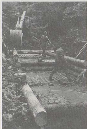
Das IBS versteht sich als «sanfte Renovation». Baumethoden und Baumaterialien sollen sich harmonisch in das Gelände einfügen. Hier ein Wildbach, der mit Werken aus Holz verbaut wird. (Foto A. Brühlhart)
