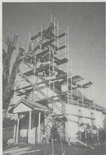
Der Turm der Kapelle Bächlisbrunnen wurde restauriert und mit einem Schindeldach eingedeckt.
