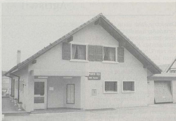
Im neuen Postgebäude in Penzers (Pensier) wurden auch Zivilschutzräume eingerichtet.
