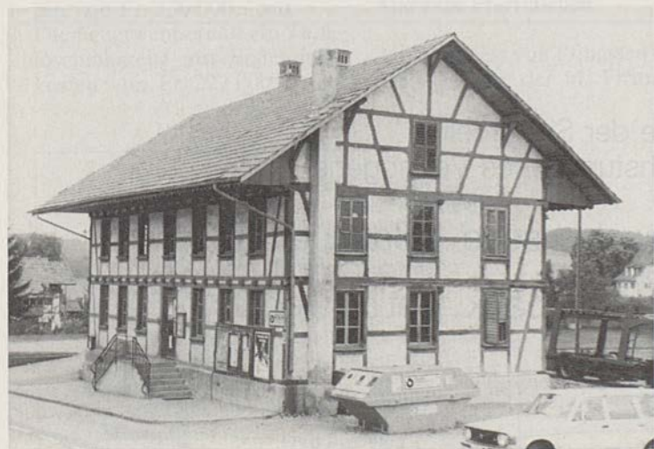
Das alte Schulhaus wurde, nachdem es 20 Jahre lang leer gestanden war, abgebrochen.
