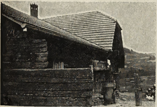
Une toiture en bien mauvais état qui a maintenant fort belle allure, dans le district de la Singine.
