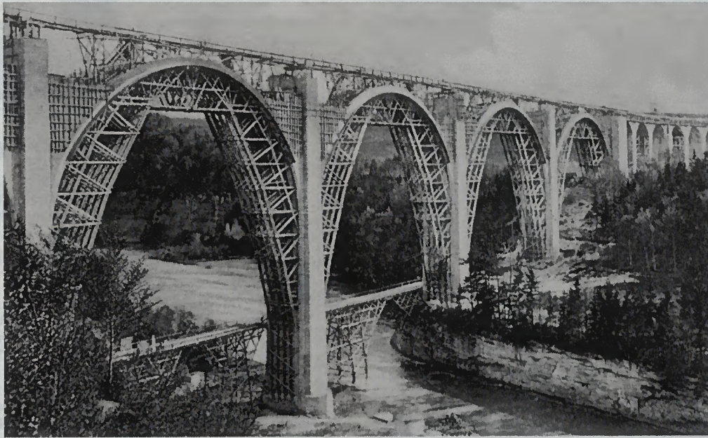
Construction du pont de Pérolles en mai 1922.
