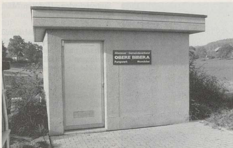
Die Pumpstation «Moosacker» bei Liebistorf stellt ein wichtiges Element des vom Abwasser-Gemeindeverband «Obere Bibera» gebauten Anschlusswerkes zur ARA Sensetal dar.
