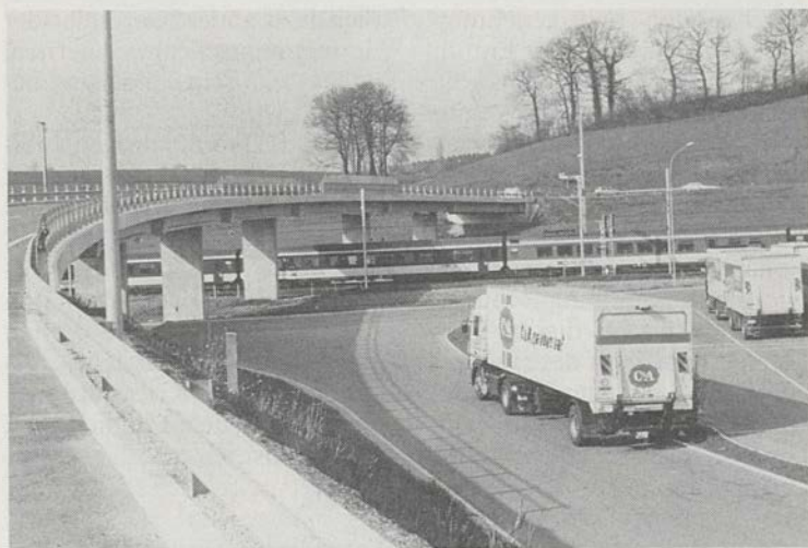
Neue Strassen führen zu Leistungsabbau bei den SBB. Überführung in Schmitten.
