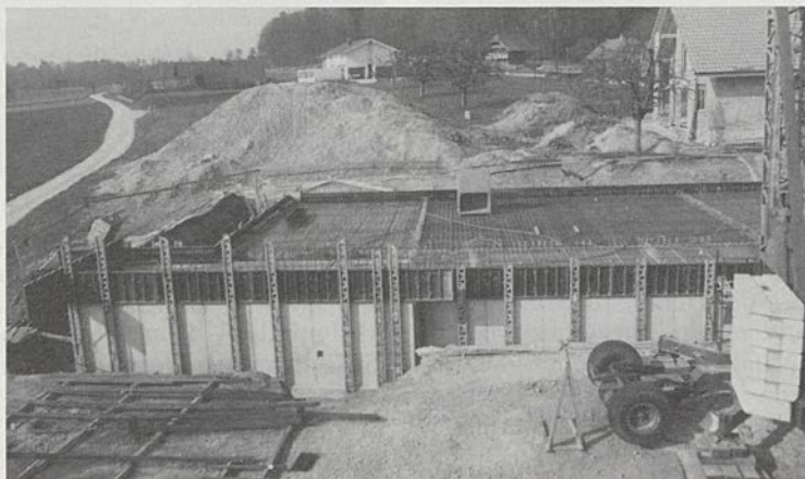
Der Zivilschutzraum im Oberfeld, der 200 Personen Schutz bieten wird, stand im Mai im Rohbau fertig.
