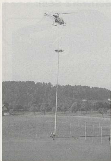
Der neue Sportplatz erhielt auch eine entsprechende Beleuchtung, wobei für das Setzen der Lichtmasten ein Helikopter eingesetzt wurde.
