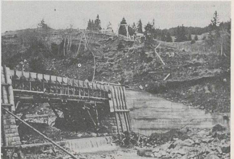
Bau der Tatiärenbrücke über die Argera 1955.
