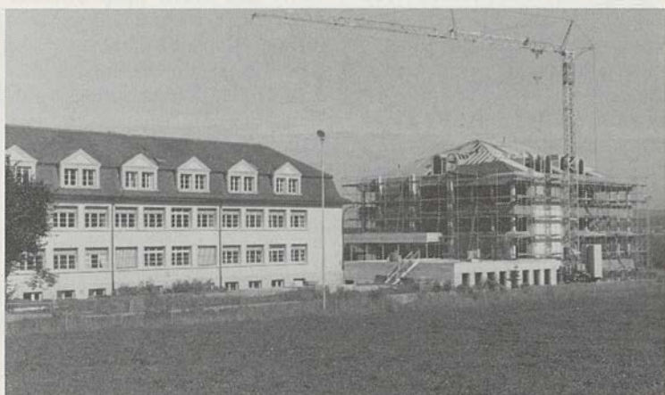
Das «neue» Schulhaus wird für rund 6 Millionen Franken erneuert und erweitert.
