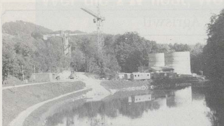
Die Arbeiten an der ARA in Penzers (Pensier) schreiten planmässig voran.
