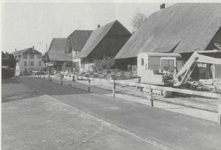
An der Fräschelstrasse wurde ein Trottoir eingebaut.
