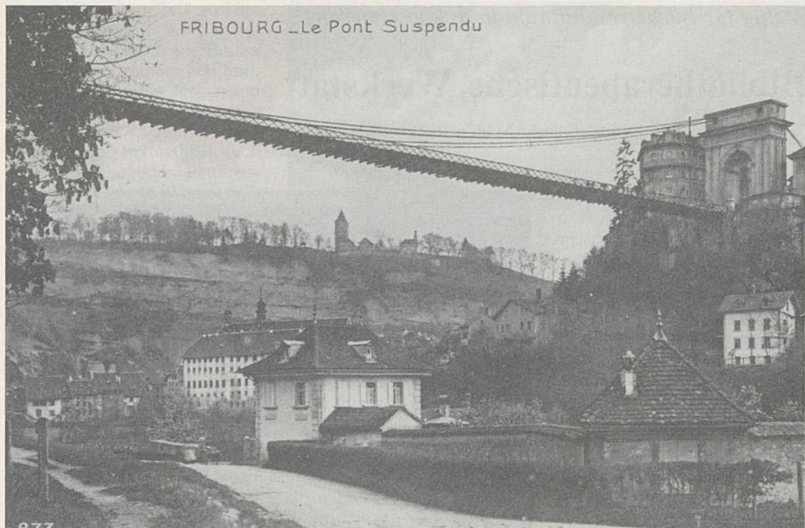
Die Hängebrücken – hier die grosse Zähringerbrücke, die 1832–1834 von Joseph Chaley errichtet wurde – wurden zum Symbol des Aufbruchs im 19. Jahrhundert.
