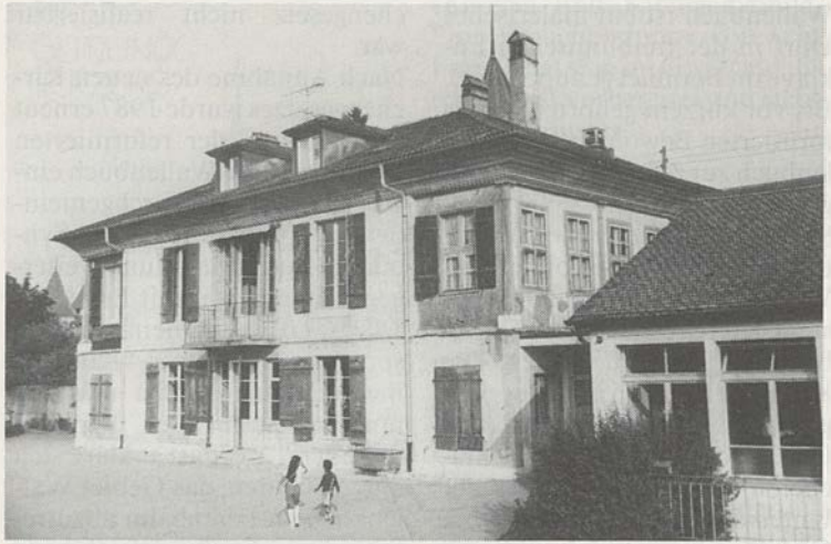
Die Fassade der aus der ersten Hälfte des 19. Jahrhunderts stammenden klassizistischen Villa, des heutigen Schwesternhauses, soll restauriert werden.
