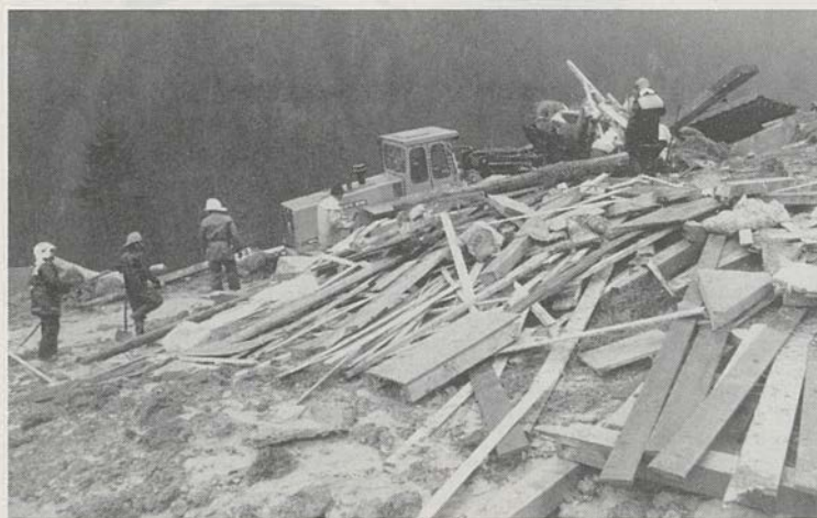
Schwere Schäden richtete im Februar ein Sturm an. In Gîte d'Allières ob Montbovon gab es sogar ein Todesopfer . Zudem wurden hier eine Kapelle und ein Haus weggeschwemmt. (Fotos Liberté)
