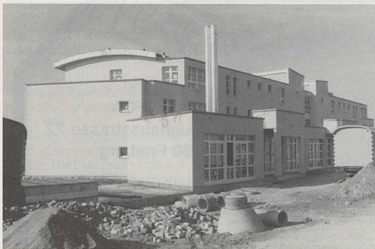
Der Bau des Altersheimes geht der Vollendung entgegen.
