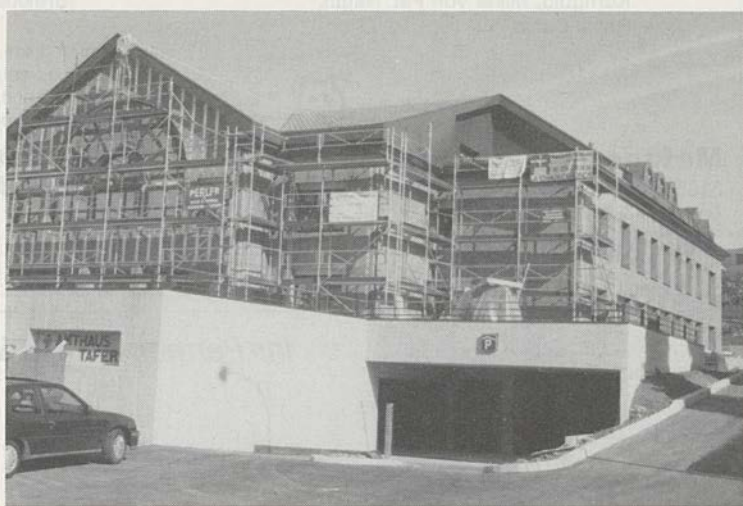
Das neue Verwaltungsgebäude geht seiner Vollendung entgegen. Stand der Arbeiten anfangs Oktober 1990.
