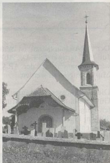
Die Kirche Bärfischen ist ein kunst- und baugeschichtlich äusserst interessantes Bauwerk.
