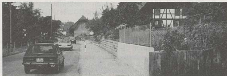
Gleichzeitig mit dem ARA-Bauabschluss wurde bereits das nächste Grossprojekt, der Bau des Trottoirs, vorbereitet.
