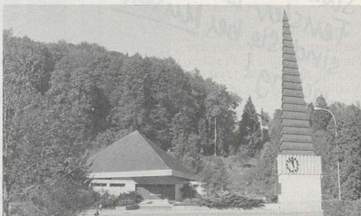
Die Davidskirche in Flamatt wurde einer Aussenrenovation unterzogen.
