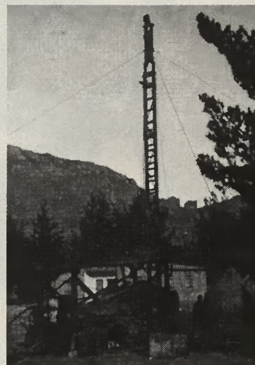
Construction d'un puits.
