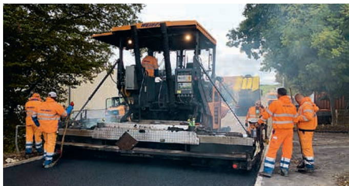
Pose du revêtement
