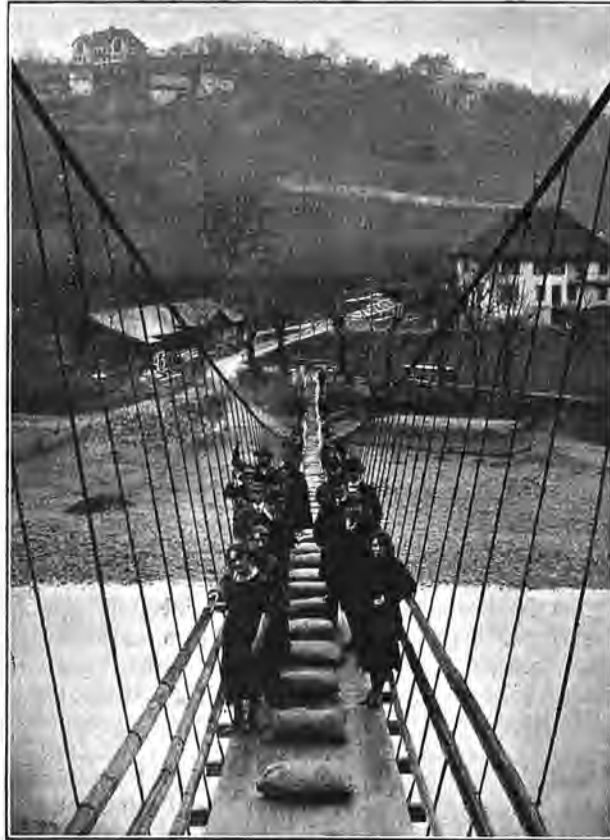
Die neue kleine Drahtbrücke beim Neiglenbad in Freiburg. (Photogr. P. Macherel, Freiburg.)
