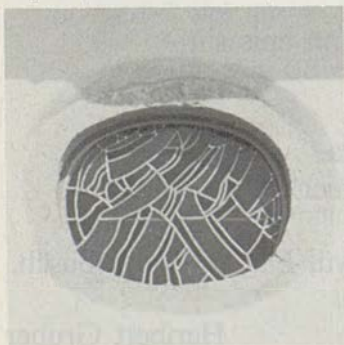
Das Fenster über dem Eingang zur Kapelle (Fotos René Bersier)
