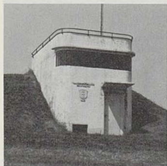
Das 1948 erbaute Reservoir «Bergli» wird in Zusammenarbeit mit der Gemeinde St. Ursen ausgebaut.
