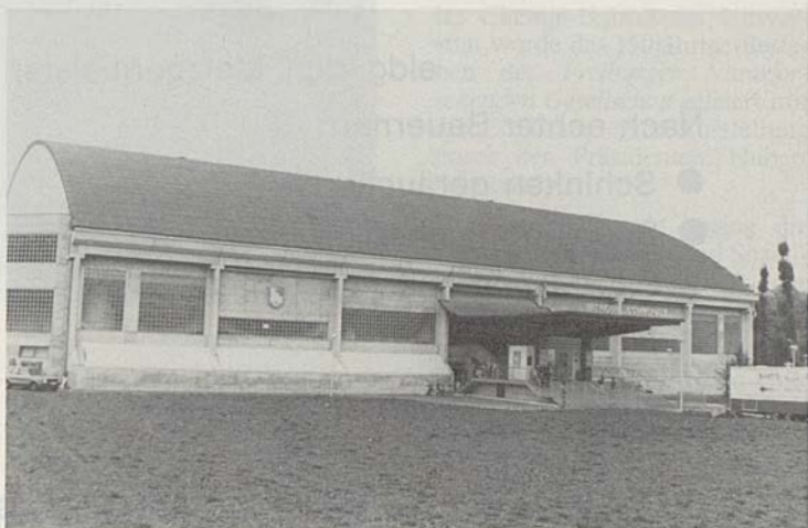
Die neue Eishalle in St. Leonhard
