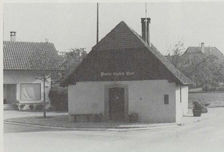
Im Ofenhaus wurde der zweite Backofen restauriert. Der Ofenhausplatz wurde mit alten «Bsetzisteinen» ausgelegt.
