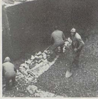
Der Eternit-Schlitzrohre werden mit einem Halbrohr aus Zement überdeckt und mit Bollensteinen umgeben.
