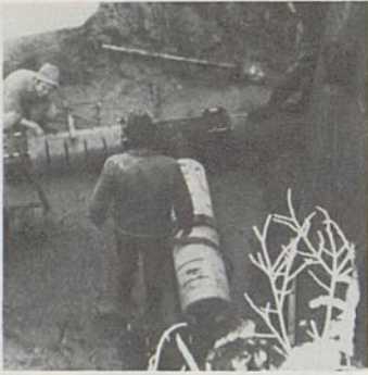
Die Eternit-Schlitzrohre, die der Wasseraufnahme dienen, werden verlegt.
