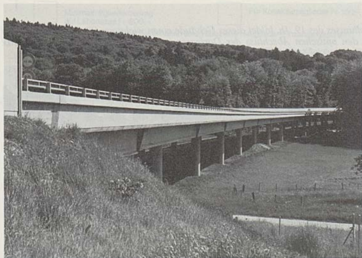
Der Autobahnviadukt bei Galmiz (Foto Autobahnbüro Freiburg)
