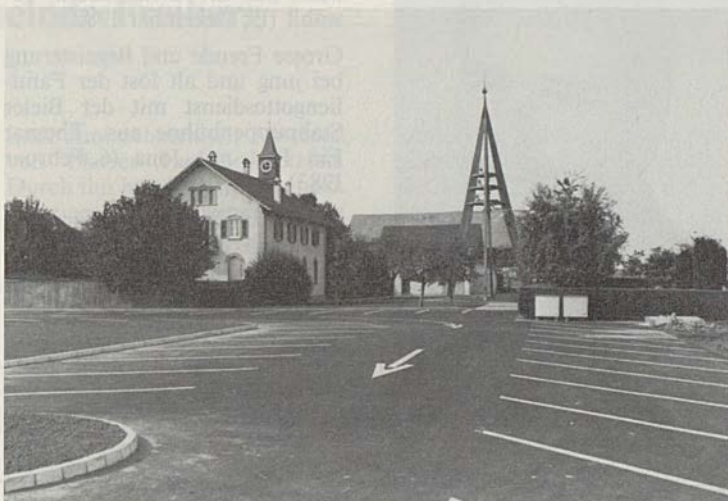
Der fertiggestellte Parkplatz bei der Kirche
