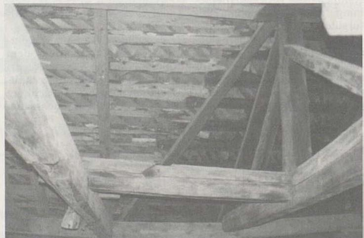
Abb. 4: Die Russspuren unter dem Dach zeigen die ehemalige Ausdehnung der ursprünglichen Hütte an.
