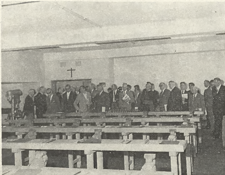
Deux ateliers sont installés dans le 3 e sous-sol, l'un pour les travaux sur fer (notre photo), l'autre pour les travaux sur bois.
