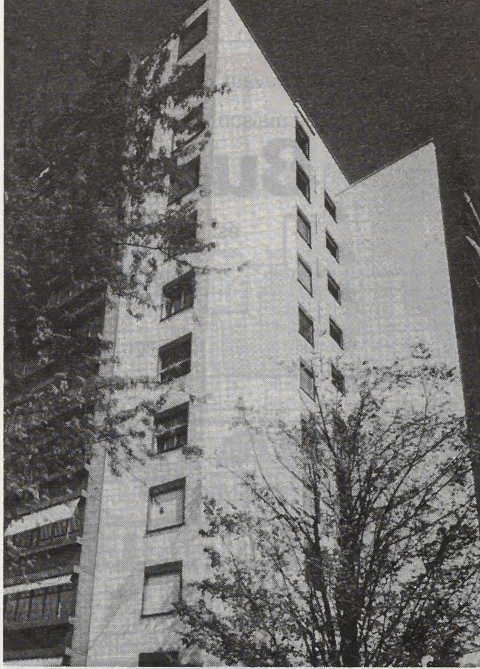
Façade rénoverée avec des éléments Vilbofa. Immeuble de référence à Glattbrugg / ZH. Photo: Villeroy & Boch
