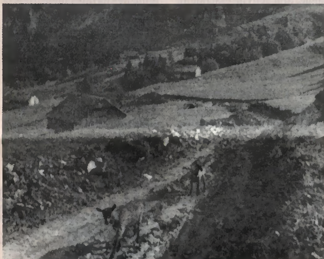
A mi-parcours, les chèvres semblent inspecter les travaux !
