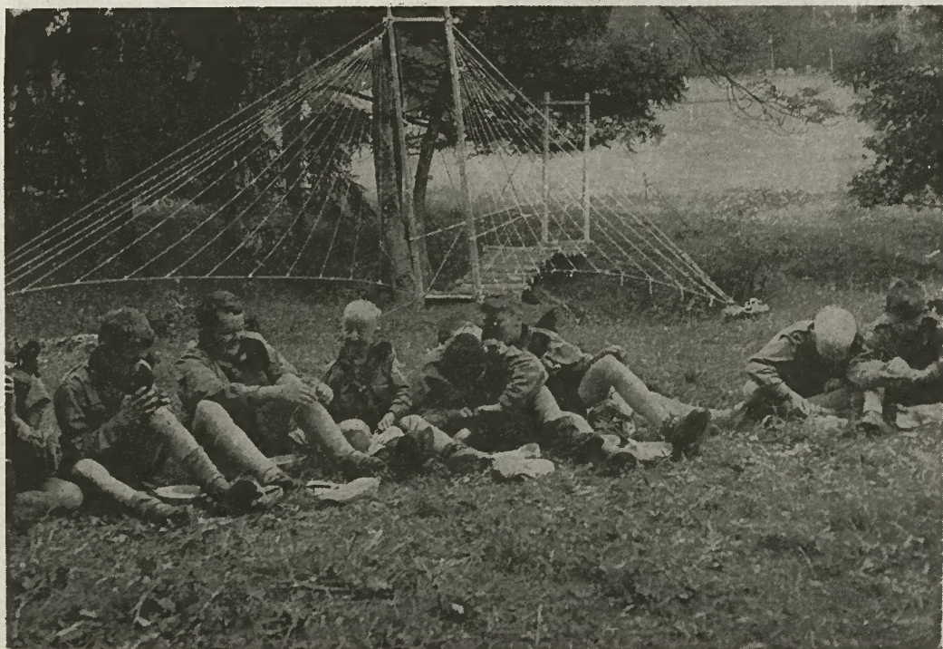
Pont construit par des éclaireurs aveugles et des éclaireurs sourds.
