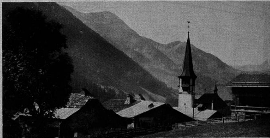
Jaun. Der Kirchturm der neuen Kirche. Blick über die Dächer hinweg ins freundliche Tal hinaus.
