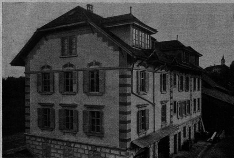
Das Haus der Darlehenskasse St. Antoni.
