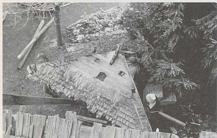
Erste Phase des Abbaus: Zu dritt wird eines der ausgehebelten Giebeldreiecke als Ganzes zum Abtransport aufgeladen.
