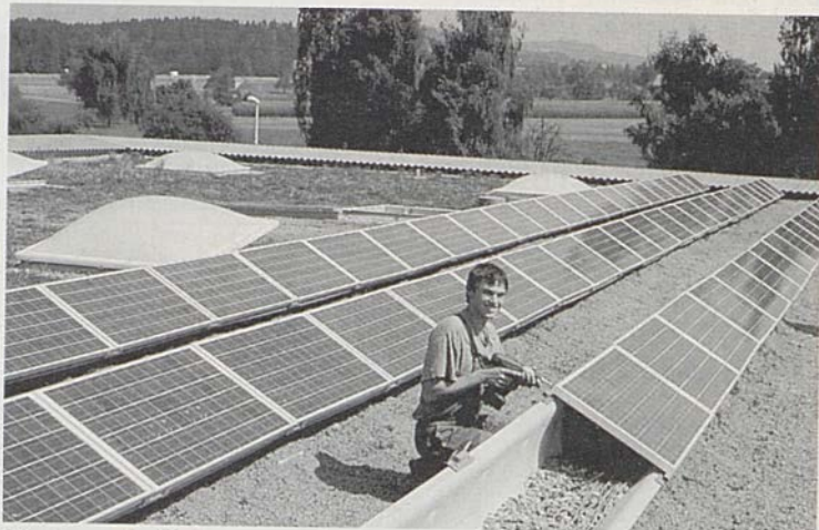
Montage der Solarstromanlage auf dem Flachdach des Werkhofs in Gossau (SG). Für die Flachdächer sind in der Schweiz eine Reihe von Montagesystemen entwickelt und erfolgreich eingesetzt worden. Die Gemeinde Gossau bietet ihren Bewohnerinnen über ihre eigenen Betriebe Solarstrom an. Quelle: Technische Betriebe Gossau (SG)
