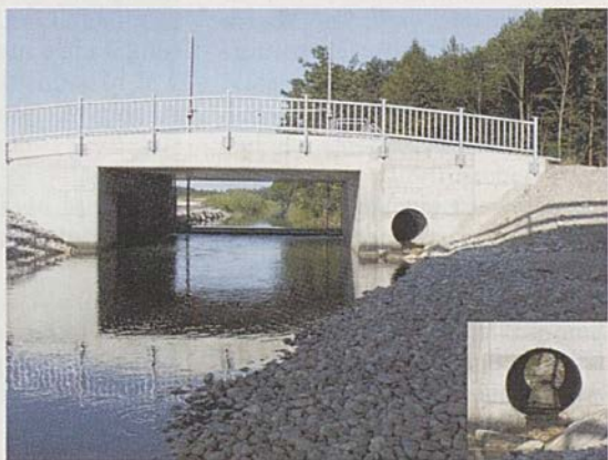
Die 1998 erstellte Biber-Passage auf der Broye zwischen Sugiez und Ins konnte anlässlich des Ausbaus der T10 durch einen Biberdurchgang ersetzt werden. (Fotos: Philippe Desbiolles)
