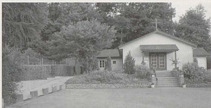
Um gehbehinderten Personen den Zugang zur Bruder-Klaus-Kirche in Kerzers zu vereinfachen, wurde eine rollstuhlgängige Rampe gebaut.
