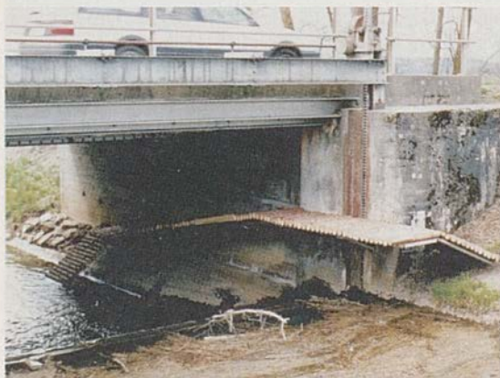
Die 1998 erstellte Biber-Passage auf der Broye zwischen Sugiez und Ins konnte anlässlich des Ausbaus der T10 durch einen Biberdurchgang ersetzt werden. (Fotos: Philippe Desbiolles)
