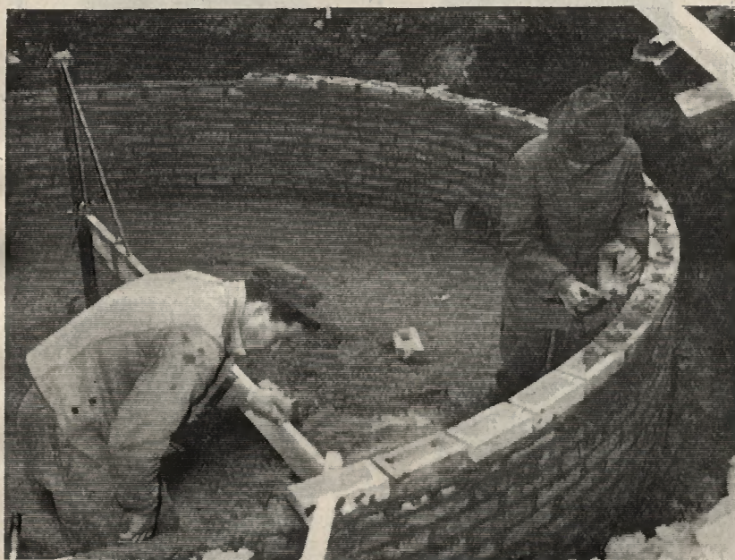
Construction d'une fosse à purin de 40 000 litres.
