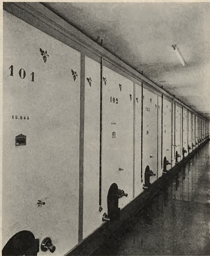
Grande cuve de stockage en cuves verrées.
