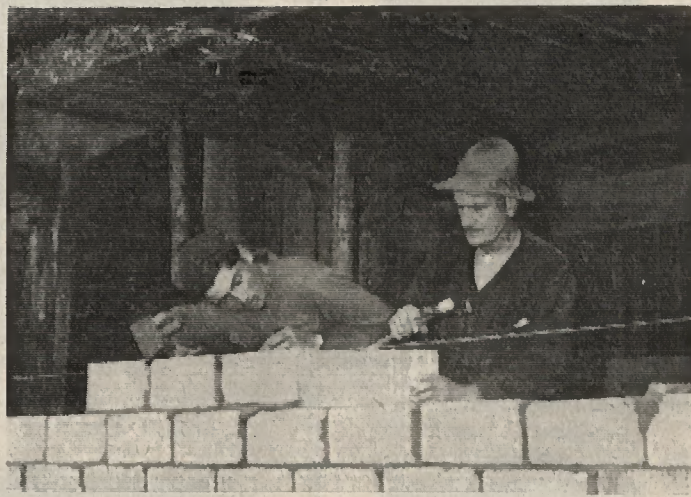
Père et fils travaillant à la construction d'un mur.
