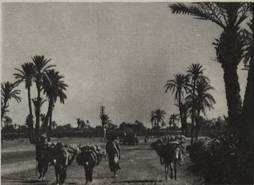
A dos de bourricots, on transporte des pierres pour la construction d'un petit pont.
