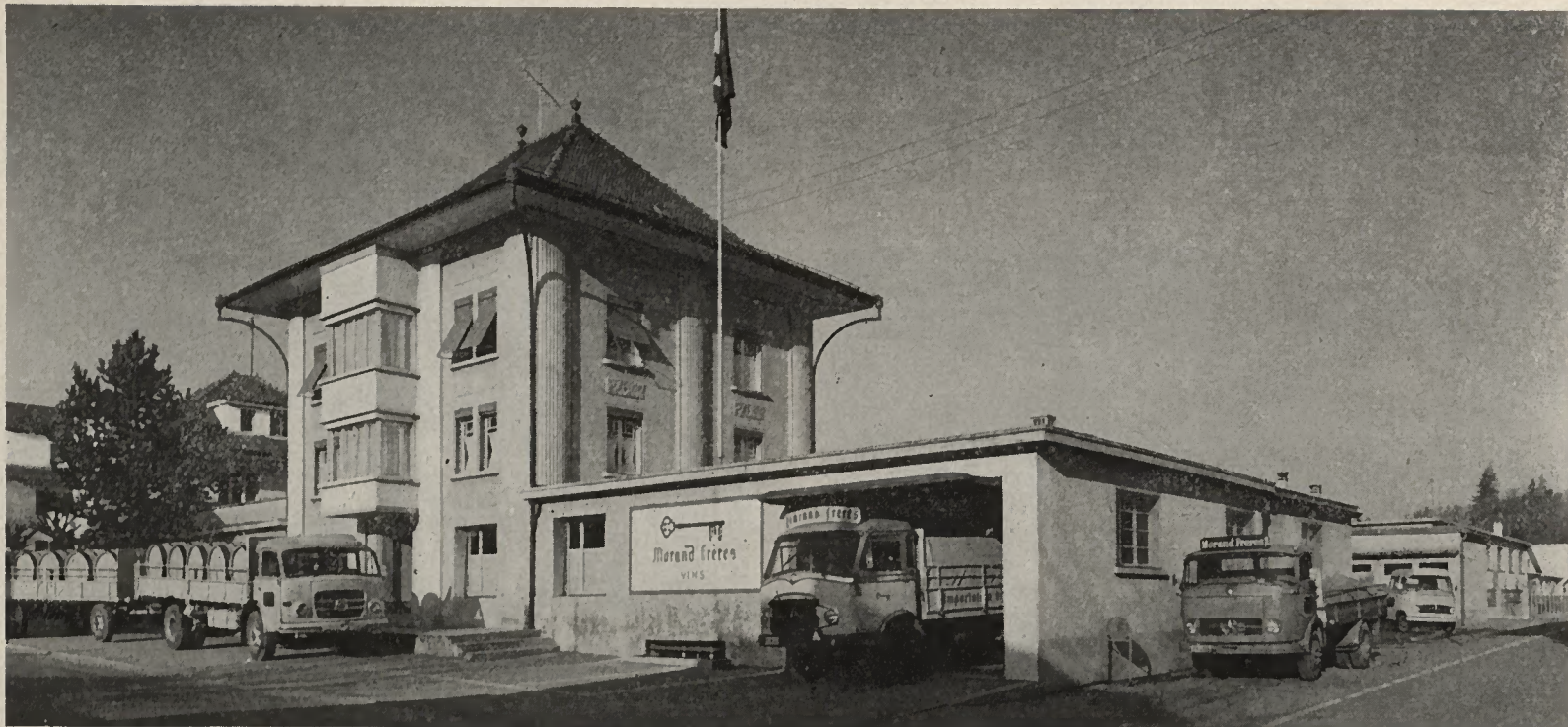
Vue du bâtiment principal et du parc des camions.
