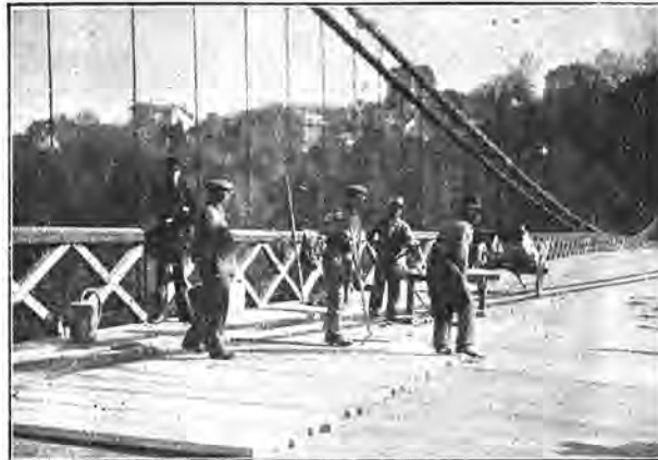
Die Brückenstadt Freiburg. Die letzte Ausbesserung an der alten Hängebrücke im Sommer 1923. Zum letzten Mal wird die Hängebrücke, die bald der festen Zähringerbrücke Platz machen und aus dem Stadtbilde Freiburgs verschwinden muß, mit neuen Brettern belegt. Mit dem Abbruch dieser Brücke wird der Zähringerstadt an der Saane ein viel bewundertes, charakteristisches Wahrzeichen genommen. Photo von Machereff, Freiburg.
