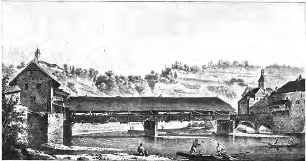
Die alte Berner Brücke bei Freiburg.
