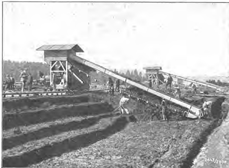
Torf-Knetmaschinen der Gebrüder Böhler von Nüzwil im Betrieb.
