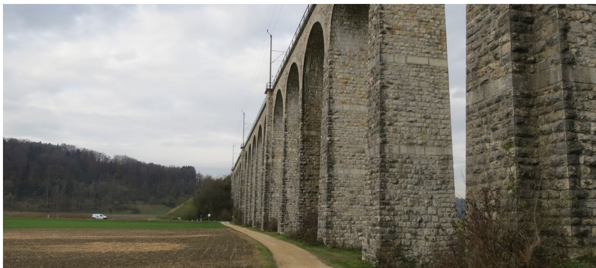
Die zwei Bilder der Saanebrücke wurden am 16. Nov. 2016 aufgenommen.
