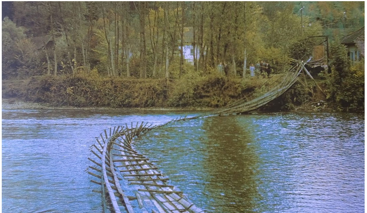
Ein trauriger Anblick: Die Hängebrücke von Bad Bonn liegt zerstört in der Saane.
