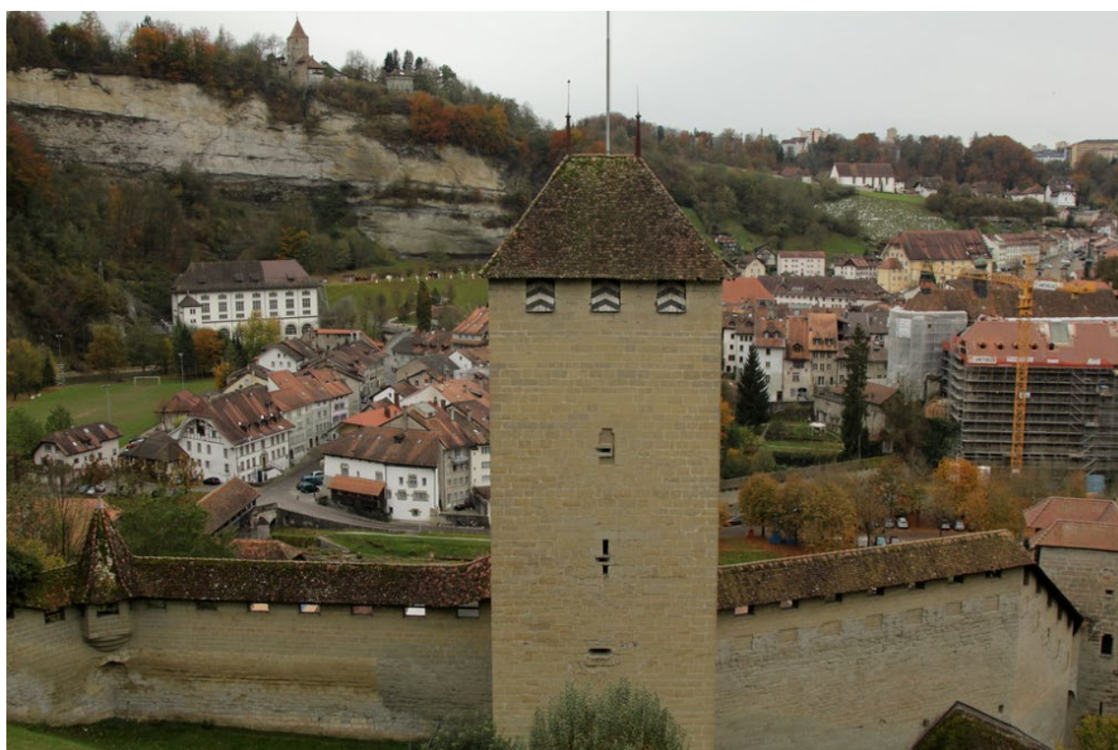
La tour des Chats , encore appelée tour du Milieu au XVIIIes., sur plan en U, à 5 niveaux, couronnée d'un crénelage sur un chemin de ronde à l'origine, achevée en 1383 par le maître maçon Rudy de Hohenberg, h 33 m. Comble en pavillon, 1428. Fermeture sud, côté ville, par une paroi en briques, suite à la mise en service d'armes à feu au XVe s. Restauration en 1919-1921.
