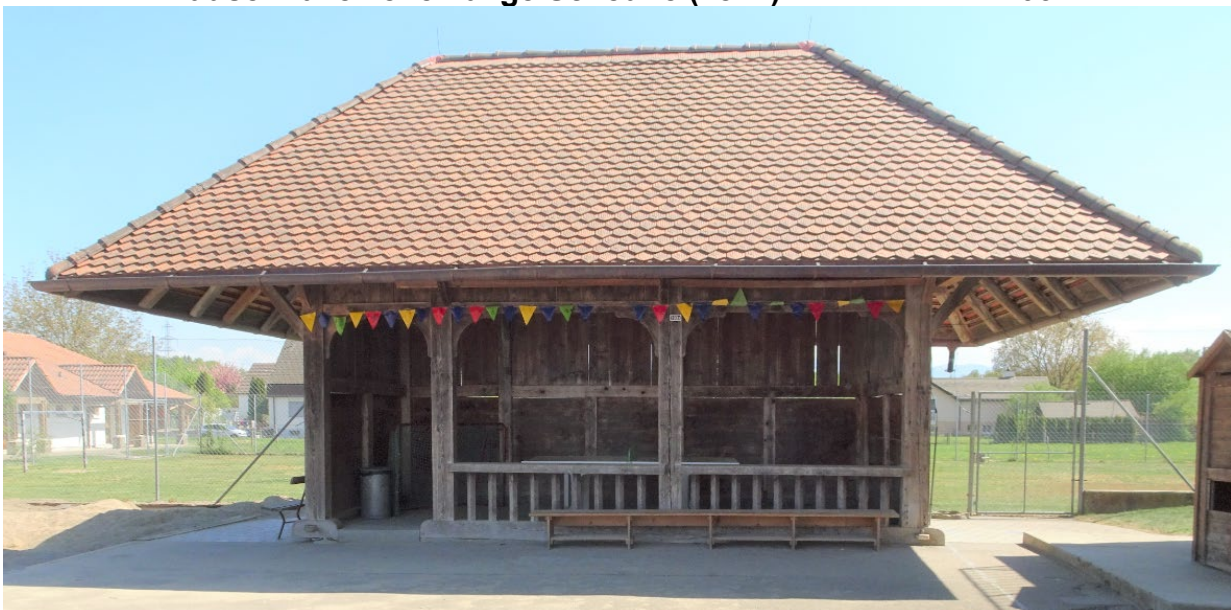
Pausenhalle / ehemalige Scheune (1847) Murtenstrasse 103a
