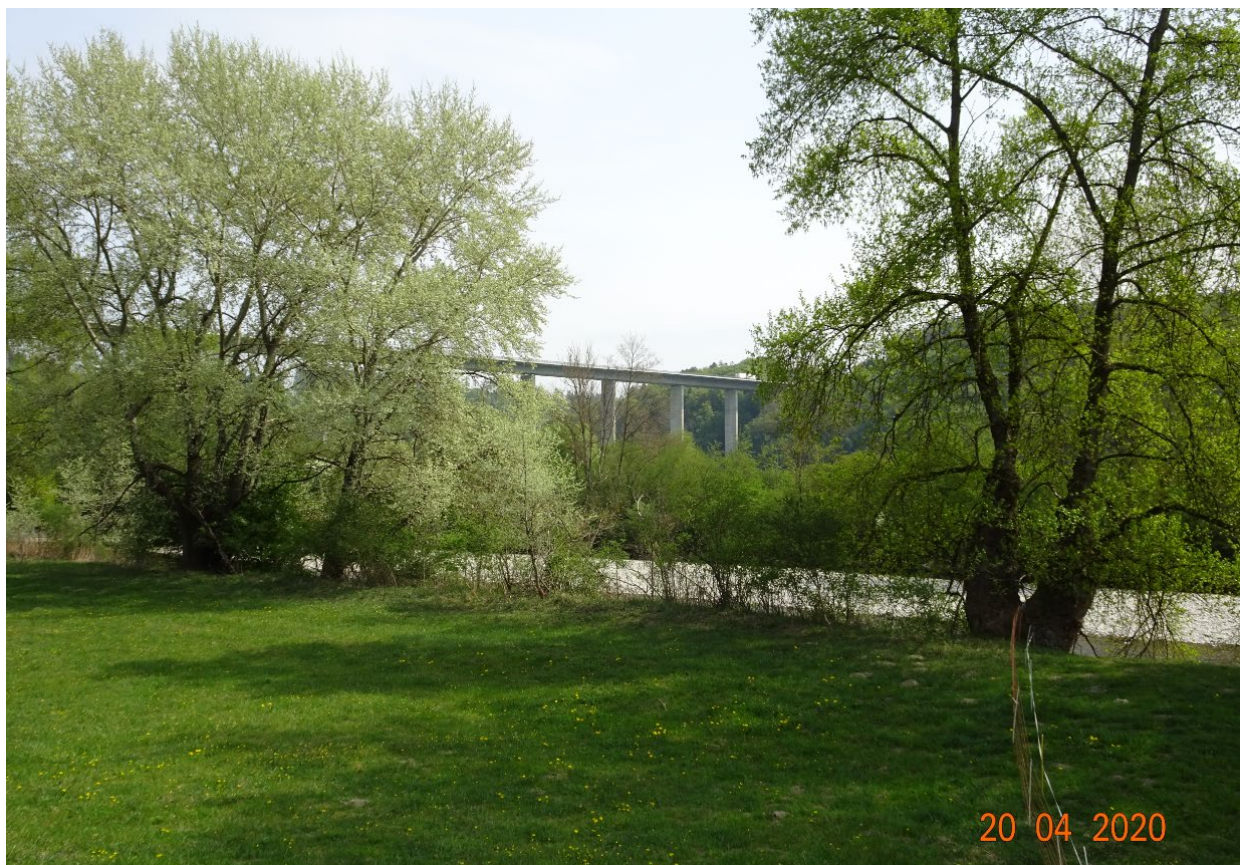
Im Hintergrund die Autobahn über den Saaneviadukt
