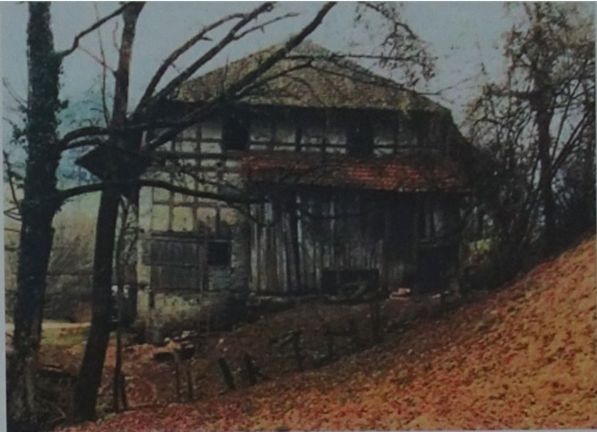
Westfassade Zustand 1989 – Foto: Verein Flühlenmühle
