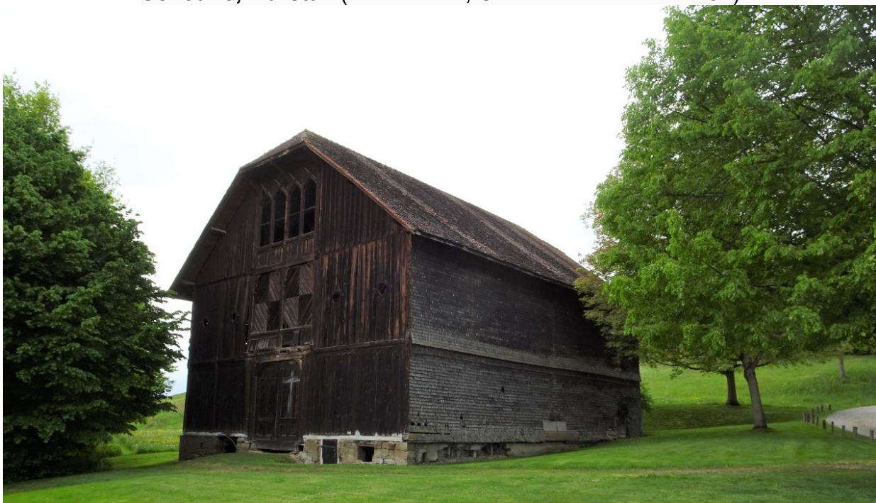
Scheune, Marstall (Barberêche, Chemin de la Fruiterie 5a)
