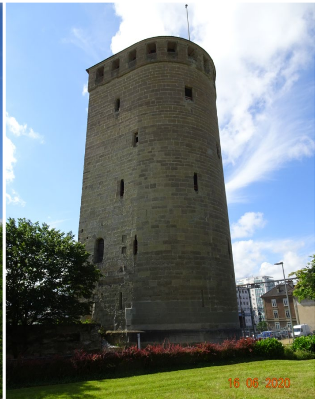
La tour Henri, sur plan en fer à cheval, à 7 niveaux, h 31 m, formant l'angle de la 3e enceinte occidentale aux deux tiers disparus, dès 1397 sous la direction de Jean de Delle. Fondations vers 1402, construction et solivages de 1411-1413, par le maître-maçon Thierry. Couverture, chemin de ronde et hourdis sur le mur de molasse côté ville, 1649. Restaurée en 1911-1915.
