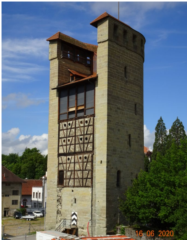
La tour Henri, sur plan en fer à cheval, à 7 niveaux, h 31 m, formant l'angle de la 3e enceinte occidentale aux deux tiers disparus, dès 1397 sous la direction de Jean de Delle. Fondations vers 1402, construction et solivages de 1411-1413, par le maître-maçon Thierry. Couverture, chemin de ronde et hourdis sur le mur de molasse côté ville, 1649. Restaurée en 1911-1915.
