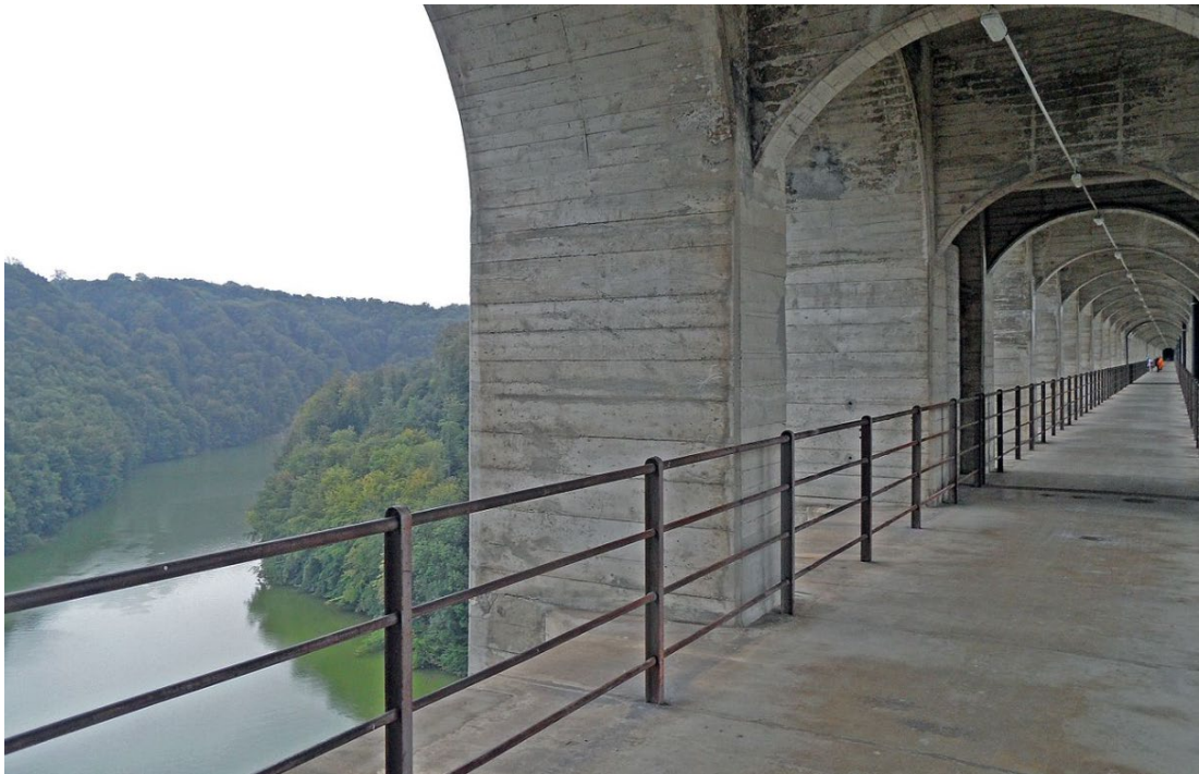
Fussgängerweg unterhalb der Schienen.
