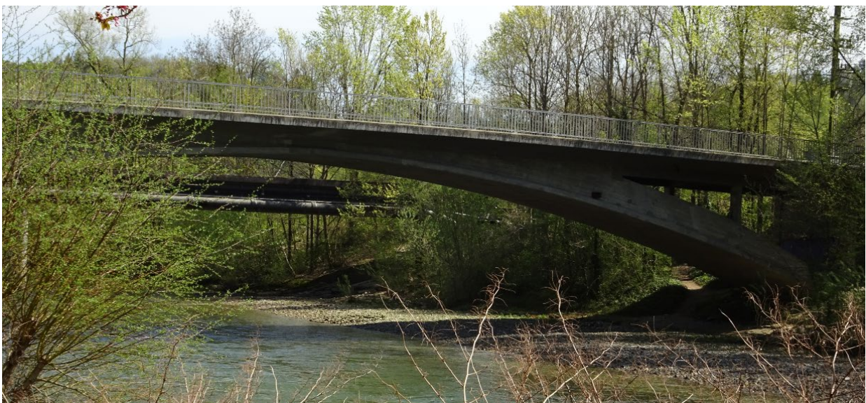
Saanebrücke Gümmenen – Laupen.
