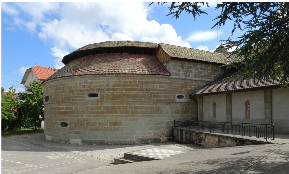
La tour des Curtils novels (nouveaux jardins), quadrangulaire, 1402-1414, et le Belluard (Bollwerk), hémicirculaire, 1490-1496, par le maçon Pierre Bergier et le charpentier Jentzli, unique de ce type en Suisse avec celui du Munot à Schaffhouse. Démolition des 2 niveaux supérieurs de la tour, 1537. Modification des canonnères du belluard, 1672 et 1683. Comblement du fossé, fin du XIXe siècles.
