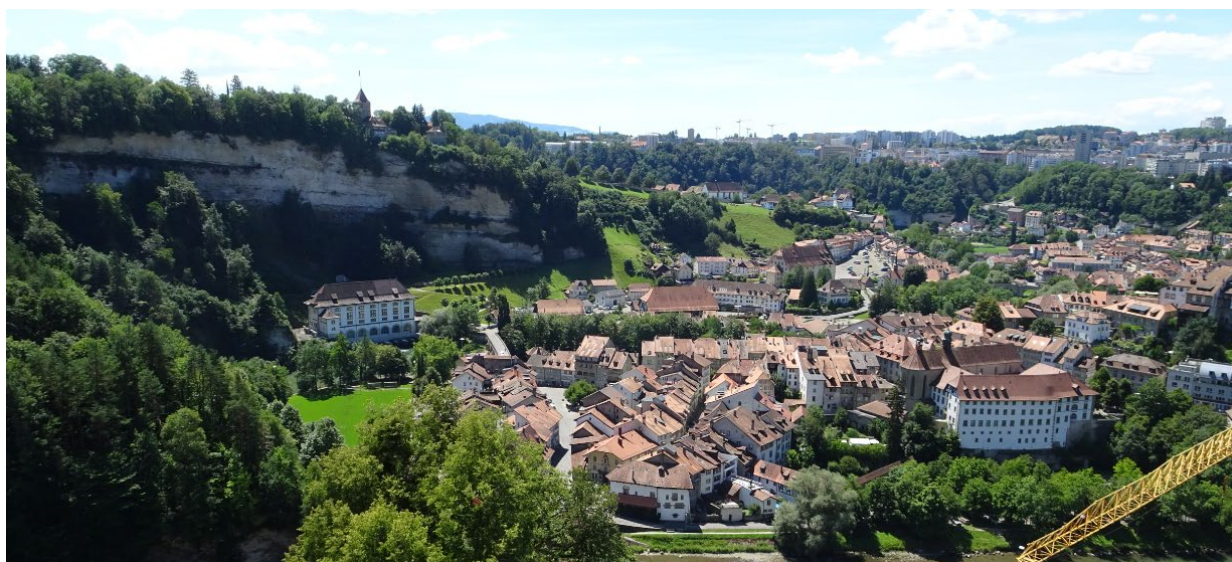
Vue sur la ville depuis le haut de la tour.
