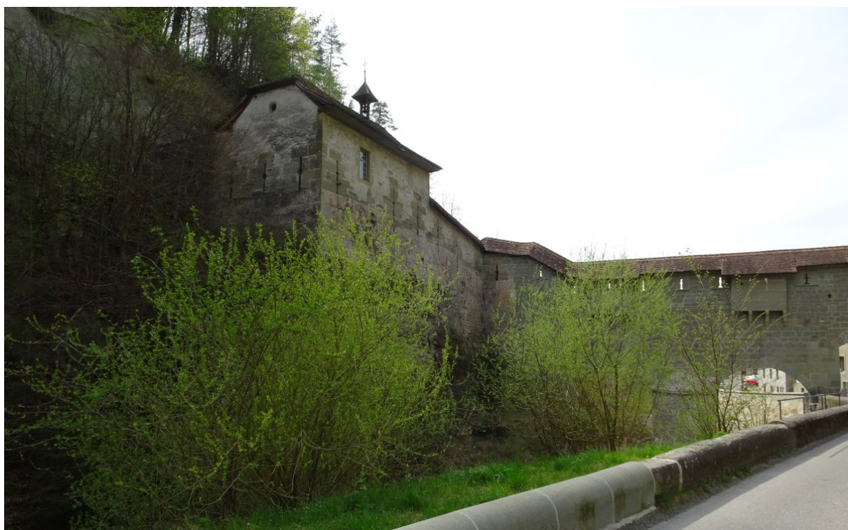
L'enceinte et la porte du Gottéron, 1376-1383, complément nord, vers 1436-1442. Couverture du chemin de ronde, 1441-1442. Saillant sud et loge de garde en pans de bois, 1586. Transformation des créneaux en meurtrières à mousquets et les quatre bretèches, 1626-1627. Élargissement de la porte en 1872, restauration en 1916-1918. Barrant la vallée du Gottéron, site des moulins.
