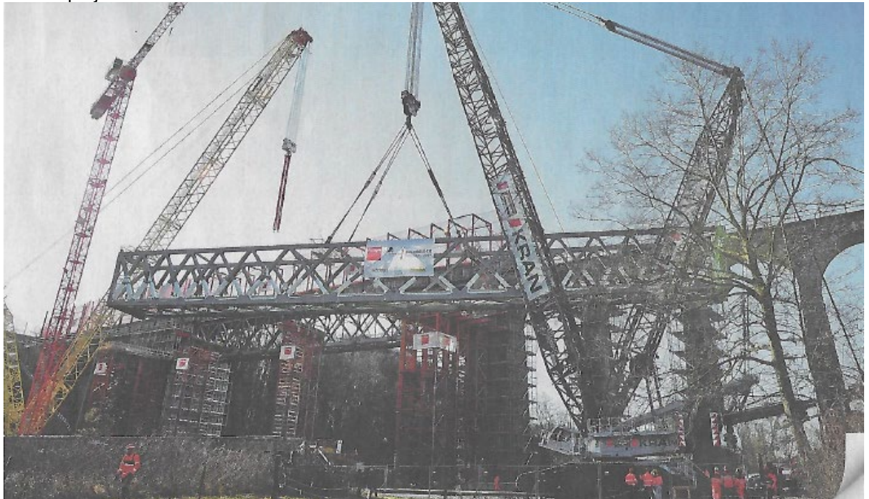
340 Tonnen Stahl werden in 20 Meter Höhe gehievt.
