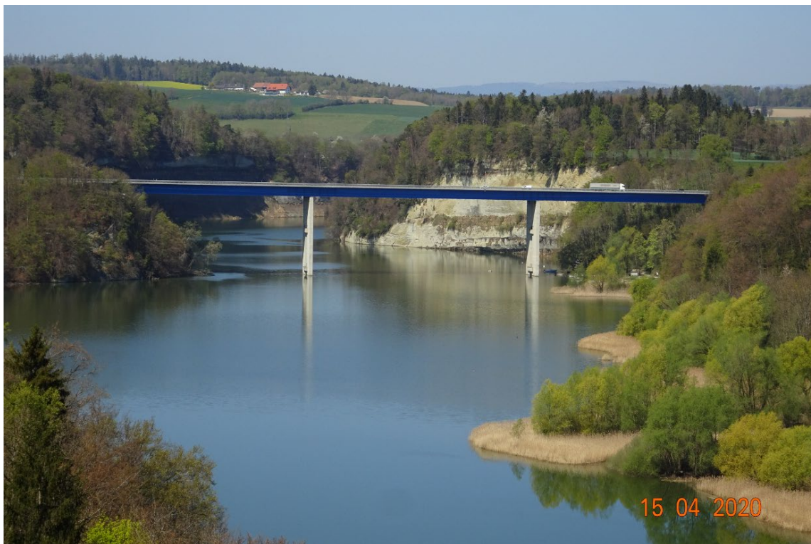
Ein schöner Blick auf die Magdalena Autobahnbrücke.
