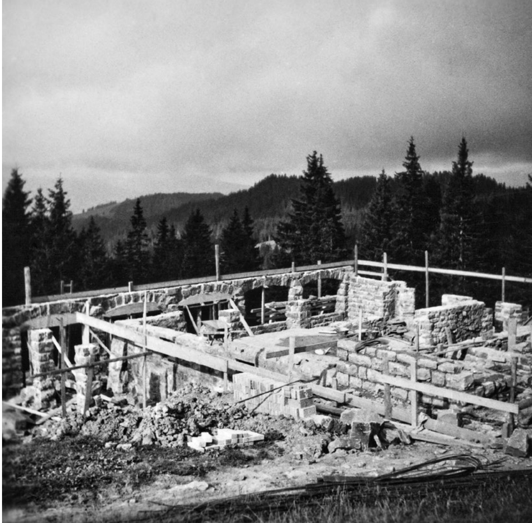
Le Gîte d'Allières en construction sur les pentes de la Berra en 1933.
