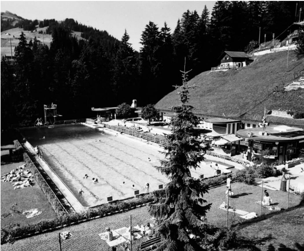
Adelboden, années 1930. La «soucoupe volante» était un kiosque à musique d'une expression architecturale particulièrement audacieuse.
