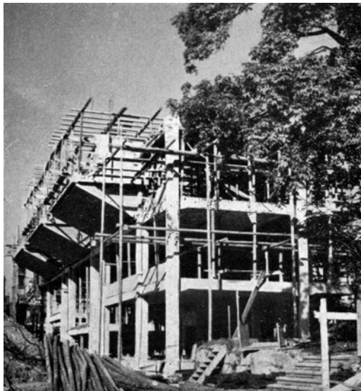
Armature de l'auditoire en encorbellement de l'Université Miséricorde selon les calculs de Beda Hefti.
