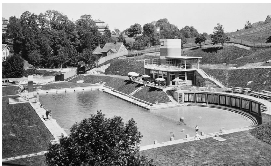
Heiden, vue du restaurant et des vestiaires intégrés dans la pente.
