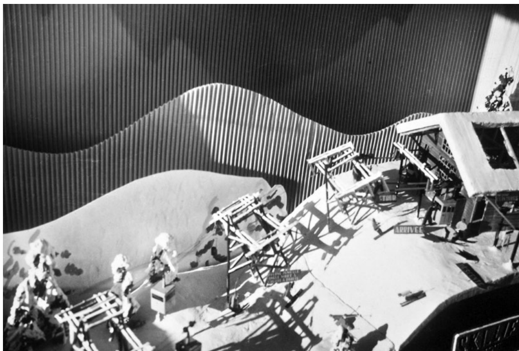
En 1939, à l'exposition nationale suisse «Landi», le téléphérique au-dessus du lac de Zurich, construit par une communauté de travail sous la conduite de la fonderie de l'usine de métallurgie de Von Roll (Berne), constitue une très grande attraction.
