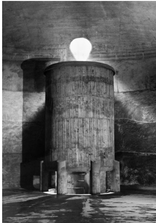
La gigantesque chambre d'équilibrage de l'usine électrique de l'Oelberg à Fribourg. Vues intérieure et extérieure.
