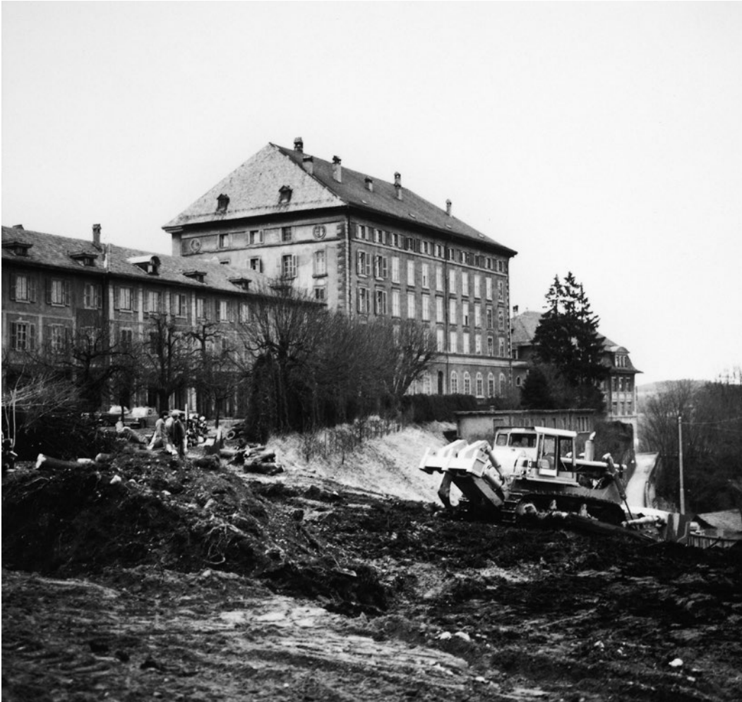
La démolition du Séminaire.
