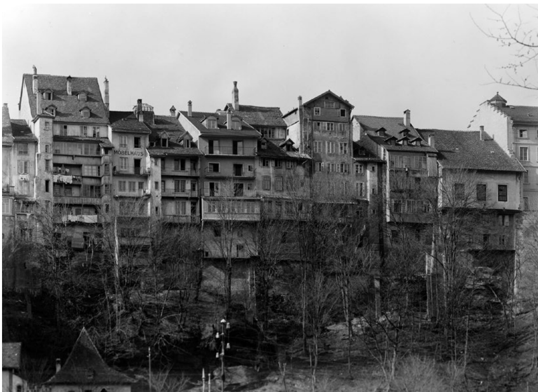
La rue des Bouchers avant sa démolition.
